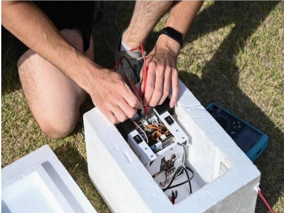
Figura 67 - Comprobación de Baterías
