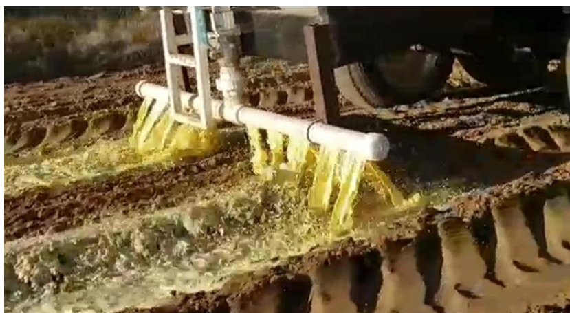
Figura 6. Distribución en obra del desgomado de soja diluido. Fuente: Secretaría de Obras Públicas, Municipio de Rivadavia
