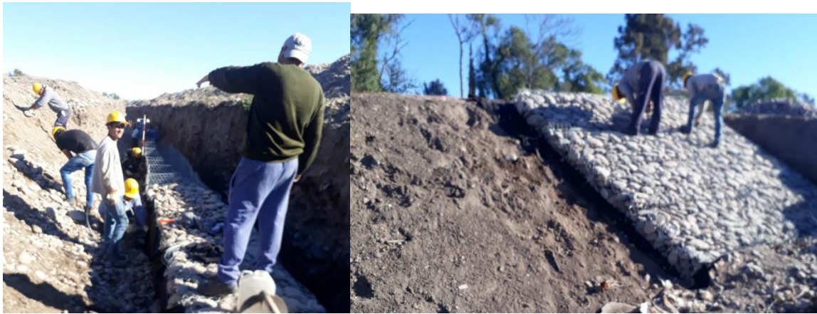
Ilustración 12. Ejecución de obras varias en defensa aluvional perimetral de La Isla.
