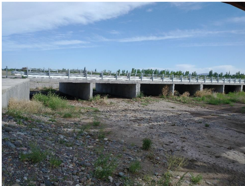
Ilustración 13. Puente de alcantarilla múltiples ubicado a 7500 m desde la calle el Toledano sobre el rio Diamante.
