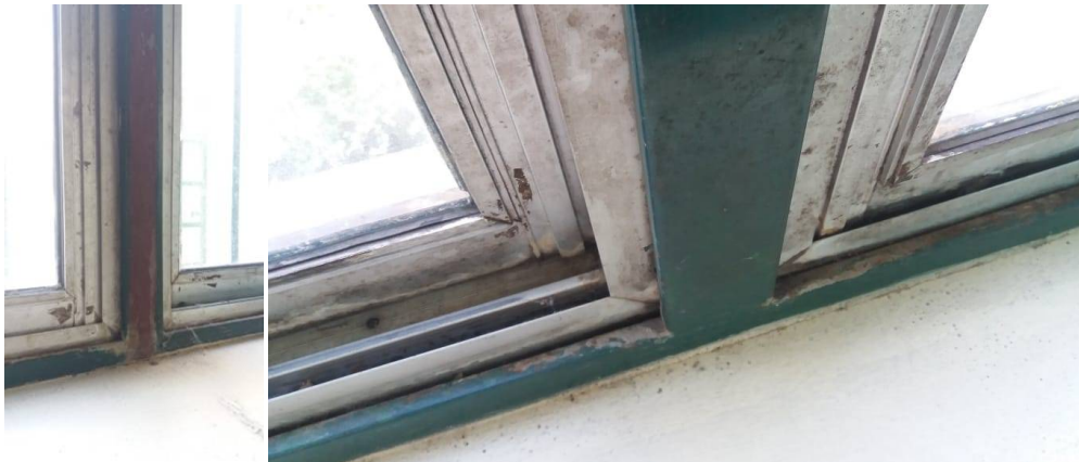
Marcos de ventanas en aulas de Planta Baja.
