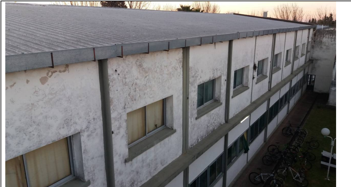
Patio interno – Muro con orientación Este – Agosto 2019 18:00hs
