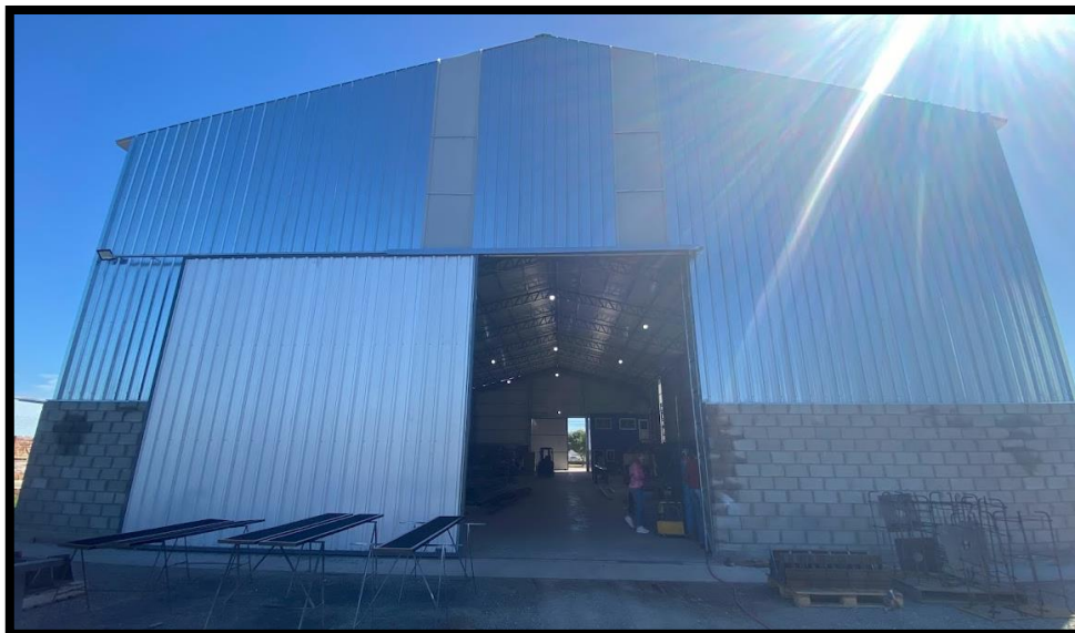
Figura N°67: Portón con salida al patio del lote.
