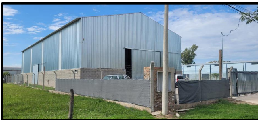
Figura N°2: Producción de estructuras metálicas y depósito de materiales.
