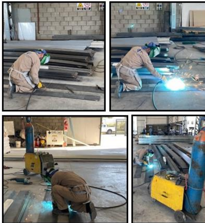
Figura N°41: Operario realizando tarea de soldadura en pieza metálica.
