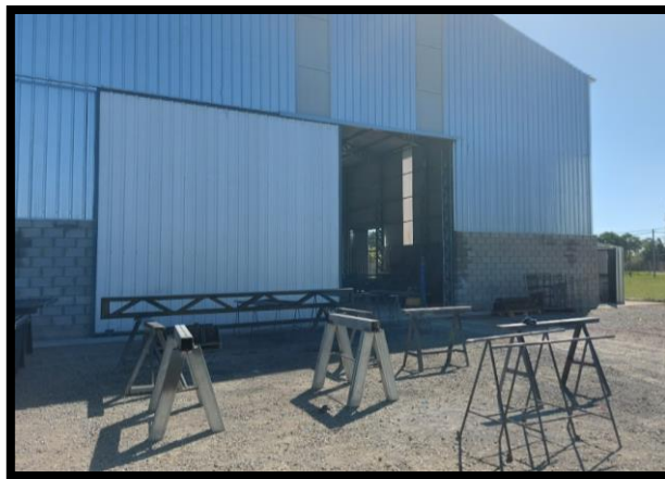
Figura N°62: Portón de ingreso desde patio.
