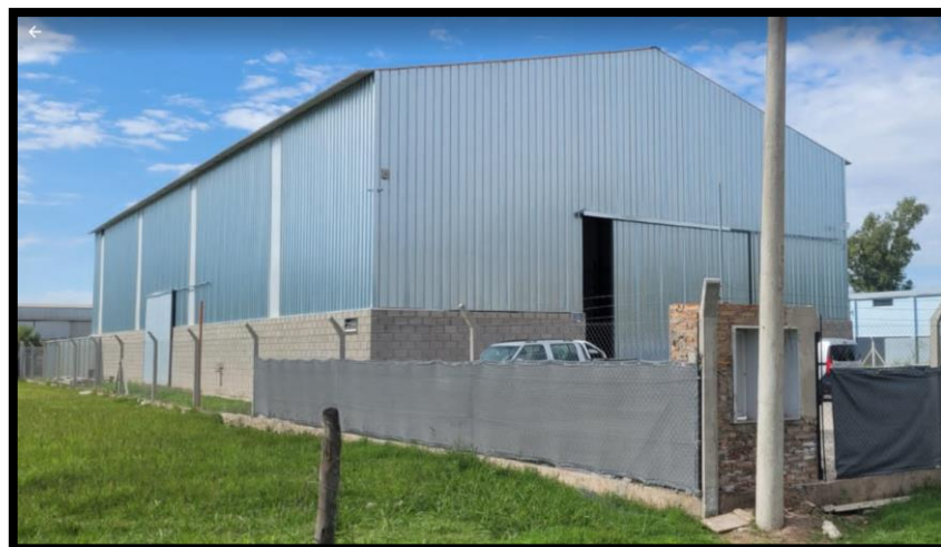
Figura N°57: Lateral del taller, fotografía tomada desde la vereda.
