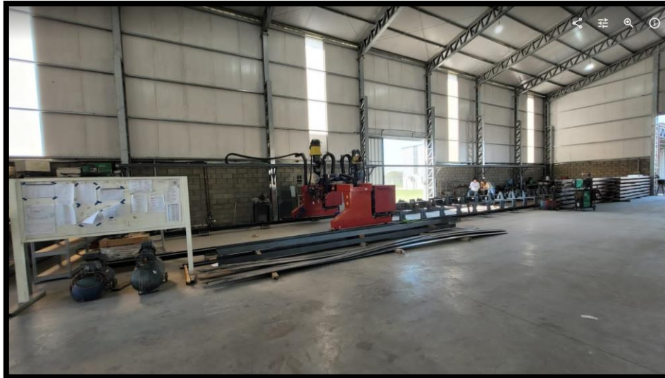
Figura N°66: Ubicación de máquina soldadora para vigas.
