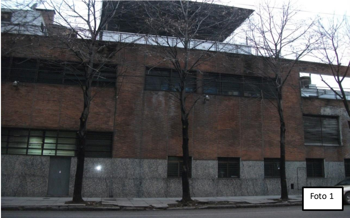
Foto 1: Vista desde el exterior, parte lateral del depósito (archivo fotográfico del ergónomo)
