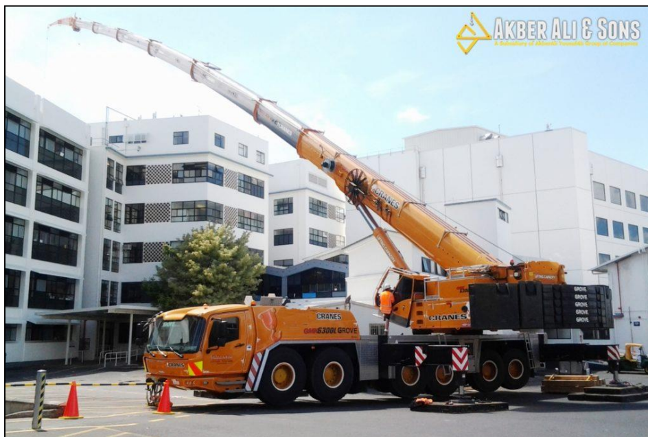
Figura 12: Camión grúa telescópica.
