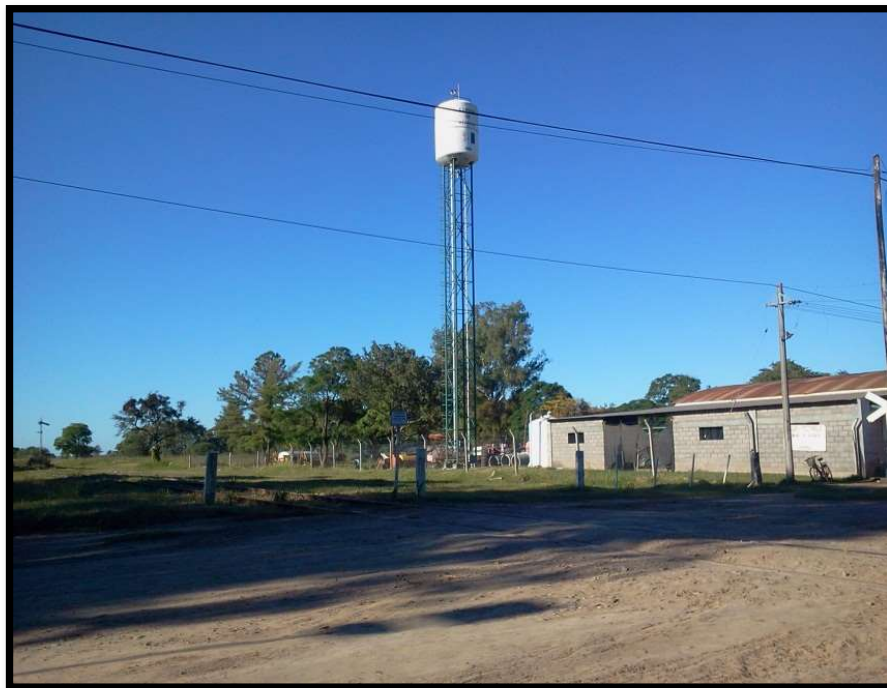
Figura 2.4- Tanque de Agua Potable de la Localidad de Hersilia.
