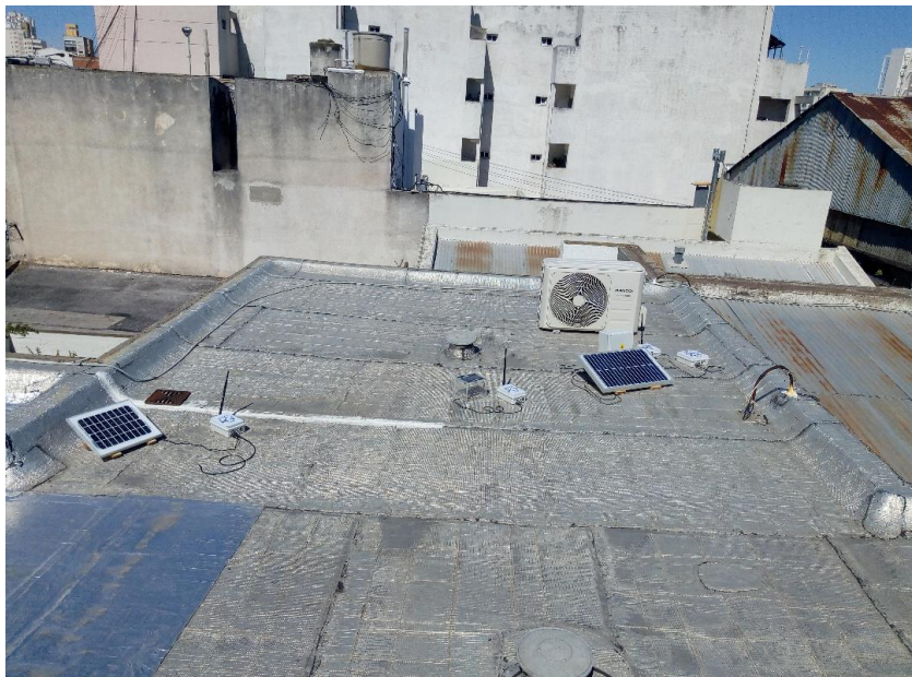
Figura 4.8: Instalación del sistema en el techo de un domicilio
