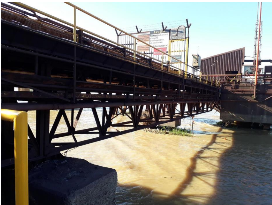
Figura 7.b: vista del puente con cinta transportadora y pasarela.
