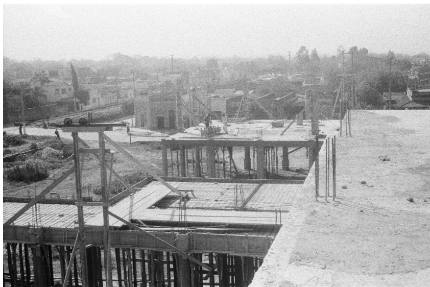
Imágenes 18 y 19. Momentos de la construcción del edificio en calle Rivadavia 1050.
