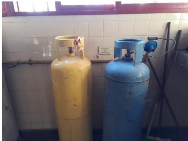
**d.1) Tomacorriente muy cercano a tubos de gas envasado:** la mala y posterior ubicación de los tubos de gas envasado, junto con su cañería que alimenta la cocina industrial presenta el riesgo de explosión debido a la cercanía con la instalación eléctrica y de gas.
