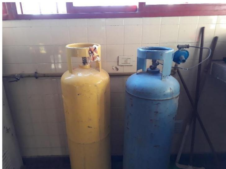
**Tubos de gas sin sujetar y próximos a tomacorrientes eléctricos**
