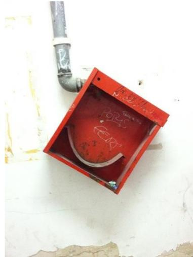
**Imagen del Relevamiento Sistemas fijos red contra incendio escuela: Gabinetes faltantes o dañados, faltantes de los soportes, las mangueras y la llave de unión, existiendo algunos hidrantes en condiciones**
