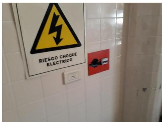
**d.2) Tomacorriente trifásico en cocina obsoleto y mal anulado:** Debido a que no se utiliza la instalación trifásica dentro de la cocina, se la dejó sin actualizar ni tampoco anulándola correctamente, con el consiguiente riesgo por electrocución debido al alto tránsito de personas que circulan a diario.
