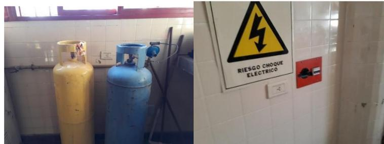
**d.1) Tomacorriente muy cercano a tubos de gas envasado:** Se propone la reubicación de los tubos de gas envasado, junto con su cañería, o en su defecto -como luego se realizó- el conexionado de la cocina industrial directamente desde el nicho de gas existente en la calle con lo cual se pudo liberar el espacio y poder así dejar en condiciones operativas y de seguridad el tomacorriente monofásico de la pared.
