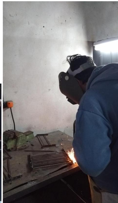
Por último, en la imagen siguiente se observa el trabajo de soldadura dentro del box (el cual está dividido por las mamparas de protección en la parte lateral, y por la campana en la parte superior), con el soldador realizando los trabajos de soldadura, utilizando los EPP recomendados.
