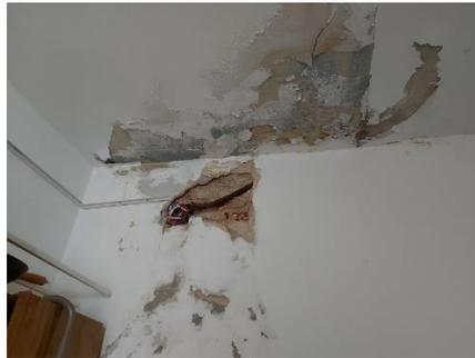
**c.1) Ingreso de humedad y agua en sector de techo/pared:** realizar la inmediata desconexión de la energía eléctrica que energiza la caja octagonal, y luego se proceder a solucionar el ingreso de humedad. Recién en ese momento se puede volver a rehacer la instalación eléctrica posterior.
