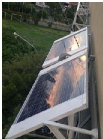
Figura 2. Vista desde la terraza.
