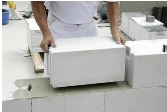
Figura 1. Sistema constructivo con bloques de HCCA machihembrados. Foto: Xella Gruppe.
