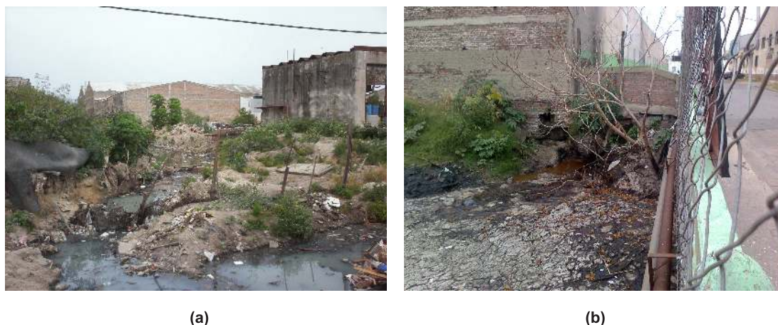
Imagen 2.20: (a) Zona de curtiembres y (b) Zona fabril, arroyo Sarandí (2011).
