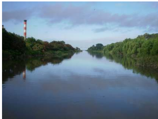
Imagen 2.10: Canal y chimenea del Polo Petroquímico (septiembre 2010).
