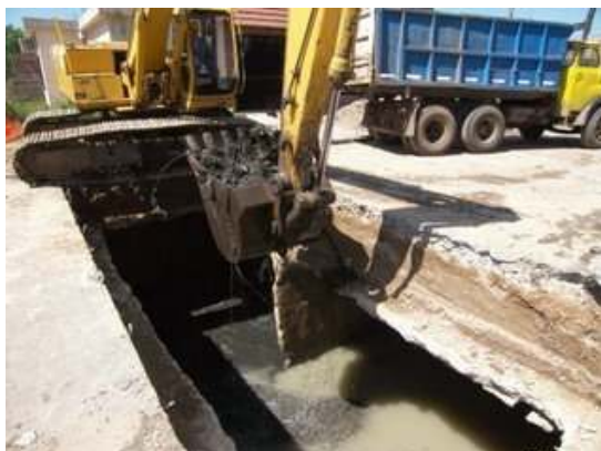
Imagen 2.16: Entubamiento del arroyo Las Perdices en Lanús. (Fuente: http://direcciondeprensadempl.blogspot.com/2007_10_21_archive.html )
