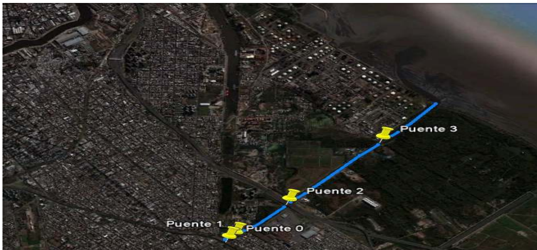
Imagen 2.19: Toma satelital de los puntos de muestreo de calidad de agua. (Fuente: Google earth)
