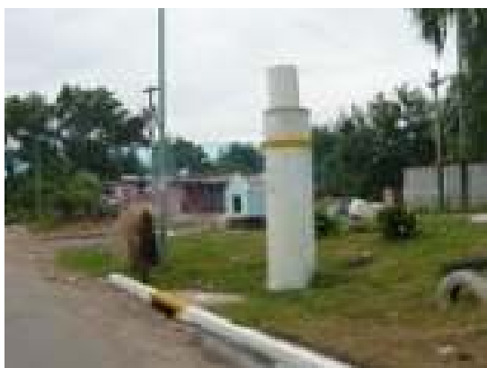
Imagen 2.17: Chimeneas de venteo. (Fuente: agenciasuburbano.com ; 14/02/10)
