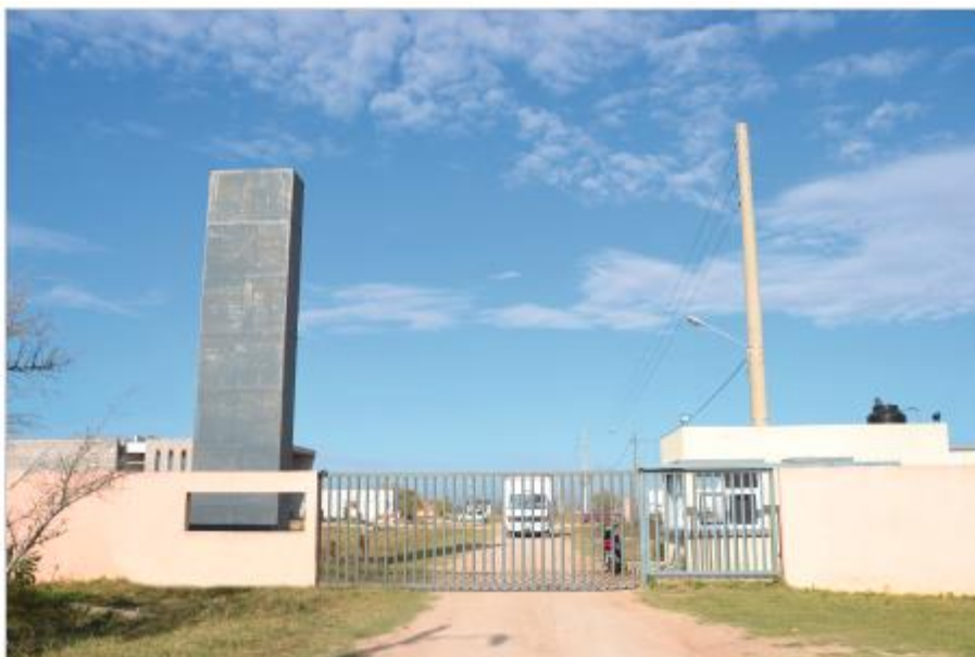
Ilustración 33 - Fachada del Sector Industrial Planificado
