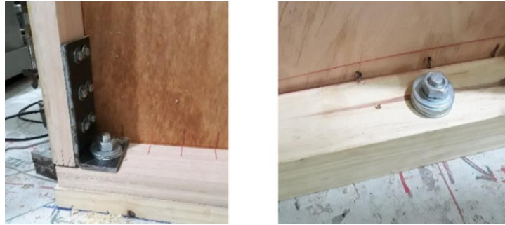
Figura 1 - Anclaje del panel. Izq.: en el parante. Der.: en la solera
