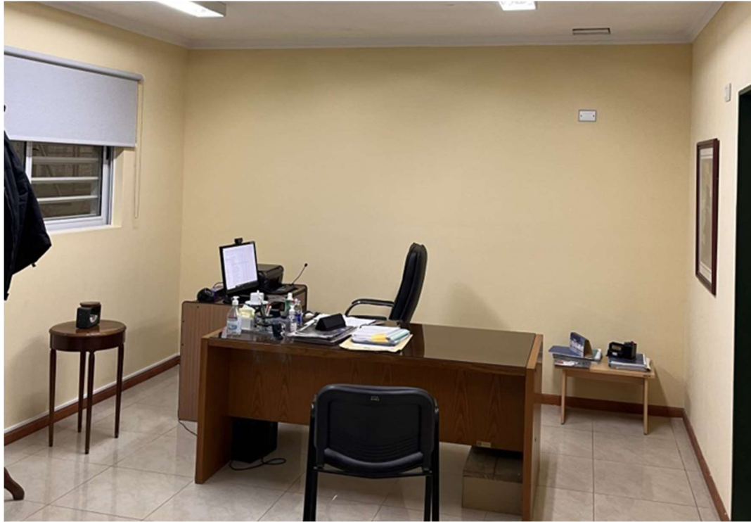
Figura 6.3.3: Oficina de decanato. Área modificada con celulosa proyectada.
