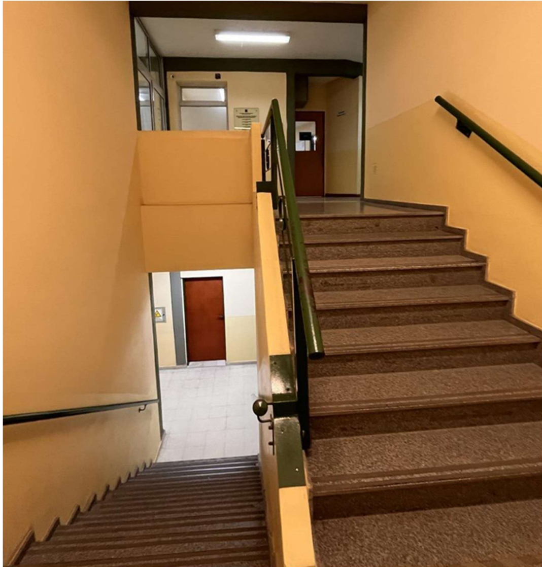
Figura 6.3.27: Escaleras. Se observa una doble altura.
