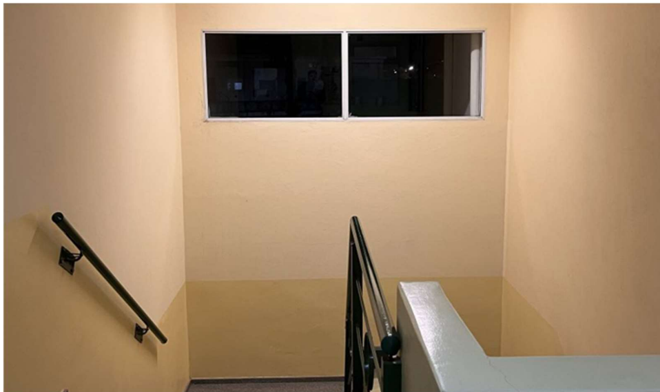
Figura 6.3.26: Escaleras. Se observa una doble altura y aberturas de vidriado simple.
