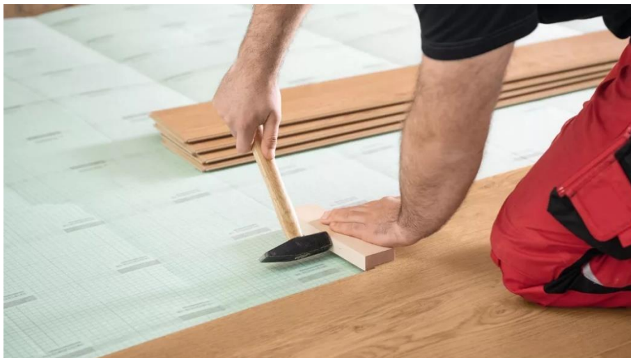
22- Colocación de pisos flotantes
