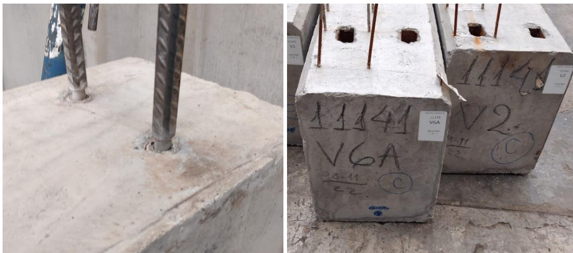
40- Barras de anclaje en columnas y orificios en vigas
