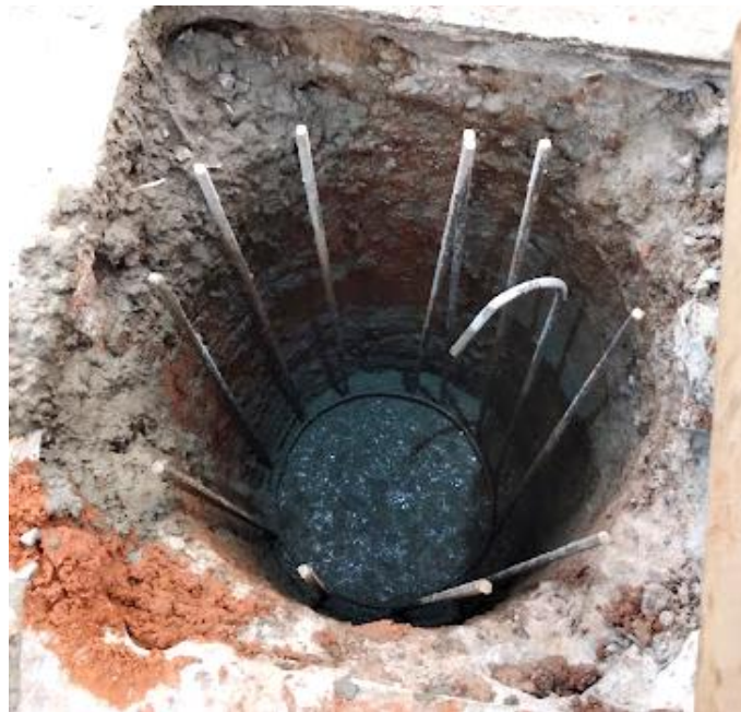
18- Pilote recientemente colado con hormigón
