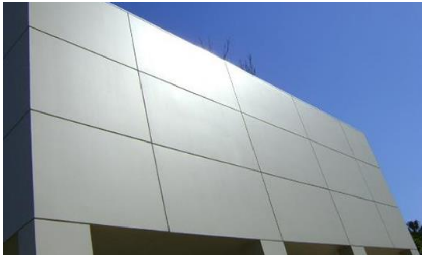
20- Frente de emplacado cementicio con junta vista
