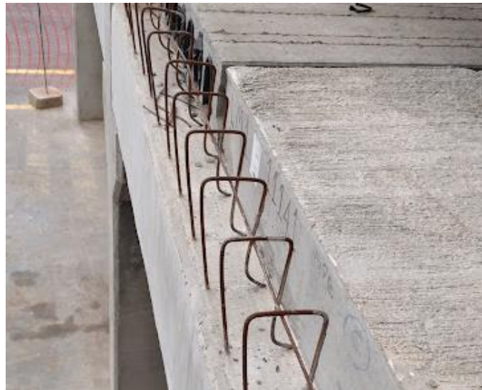
39- Losas pretensadas sobre vigas, se ven ganchos de anclaje previo al hormigonado
