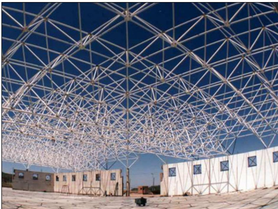
*Figura 59: Ejemplo real de estructura de dos capas*
