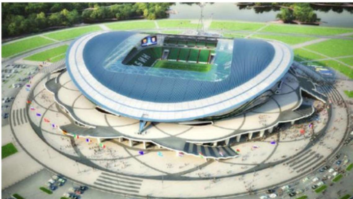
*Figura 107: Cubierta realizada con Policarbonato Alveolar*
