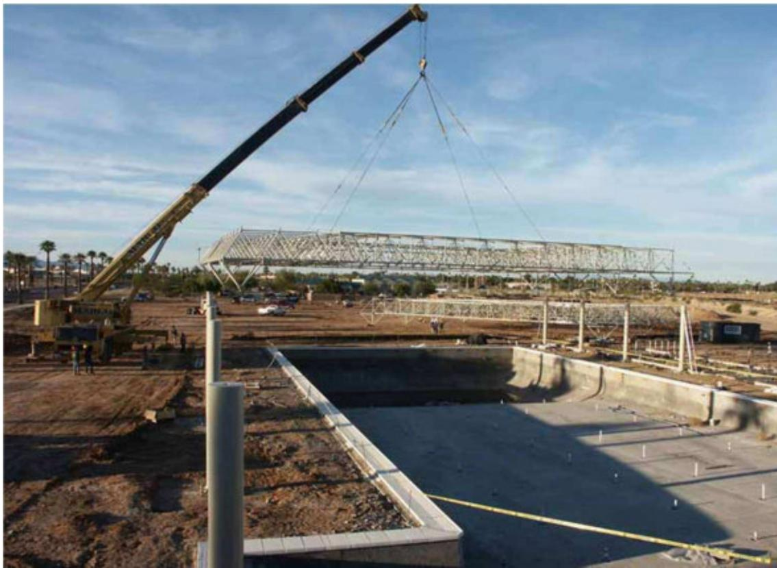
*Figura 100: Montaje con Camión Grúa (II)*
