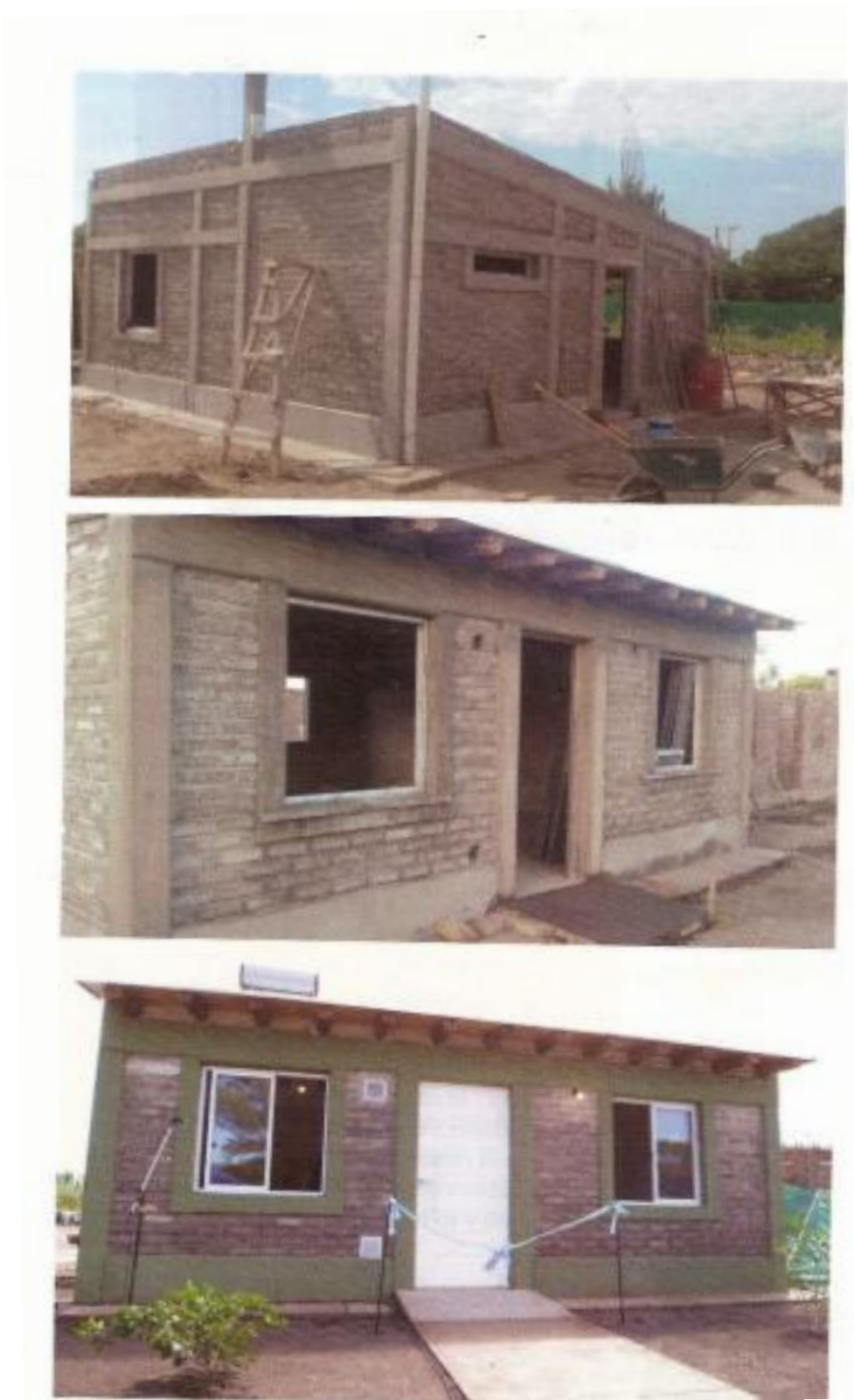
Figura 2. 11: Vivienda modelo construida con ladrillos de PET.
