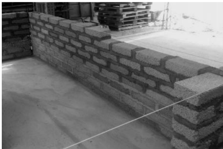
Figura 7. 10: pared en construcción de ladrillos de APR .
