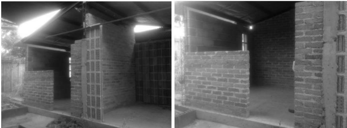
Figura 7. 14: construcción de paredes dentro de la vivienda empleando diferentes técnicas y con ladrillos de APR.
