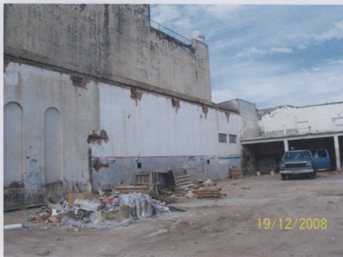
Vista de la Medianera izquierda la derecha
