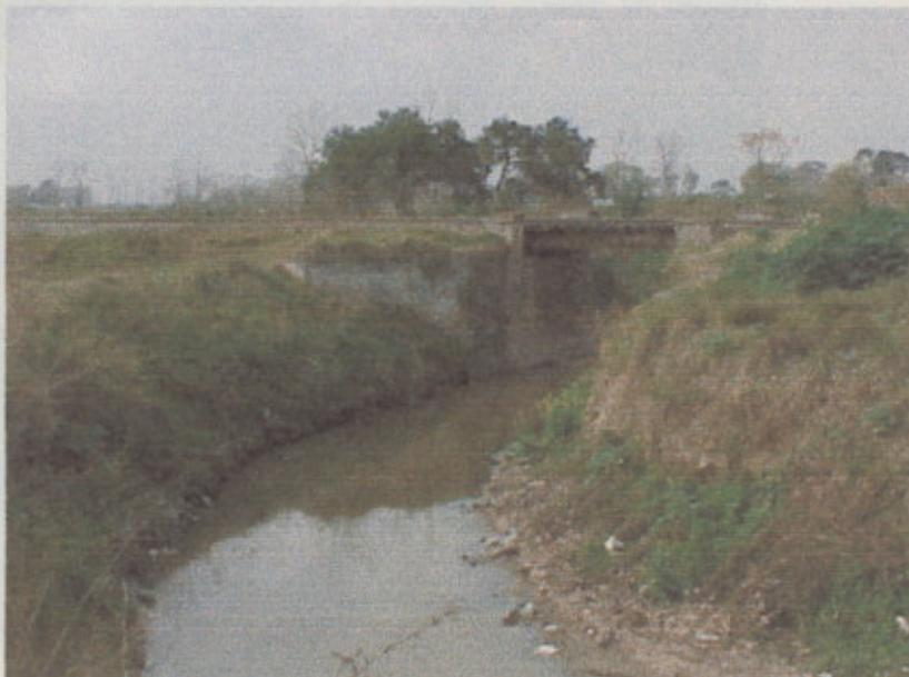
Este puente se encuentra a unos 50 m de distancia del puente de cruce de la calle Neuquen hacia aguas abajo siendo su sección muy chica y teniendo una curva anterior al puente y una contracurva pasando el puente aguas abajo.
