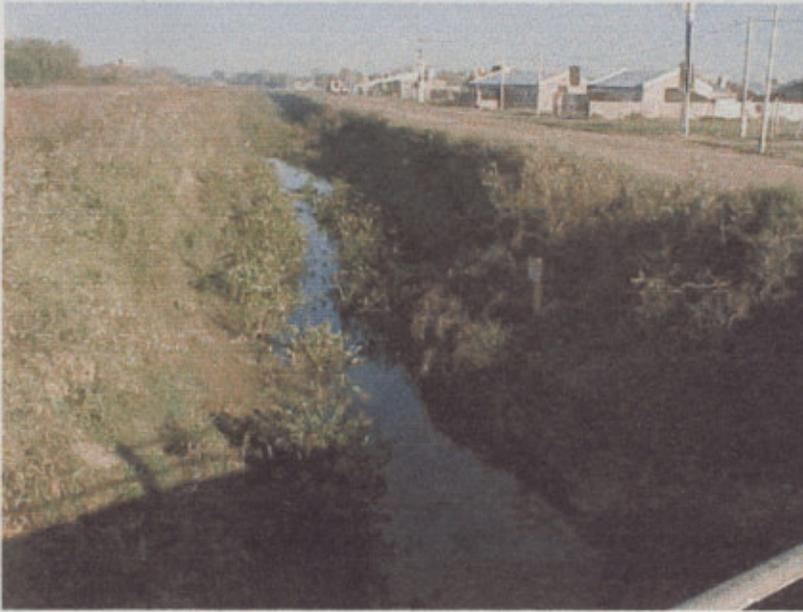
Foto donde se ve el agua que se estanca sobre el fondo de la ultima mitad del canal y no corre hasta producirse una precipitación, produciendo esto un barro arcilloso muy inestable
