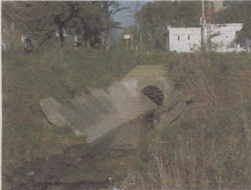
comprende a toda la parte céntrica de la ciudad y parte del barrio San Martín por intermedio de una red de cañerías pluviales desembocando en un tubo de 1.80 m de diámetro (según foto). Luego existe un revestimiento de hormigón de unos 15 m de longitud de allí en mas continua el canal en el terreno natural (según foto)..
