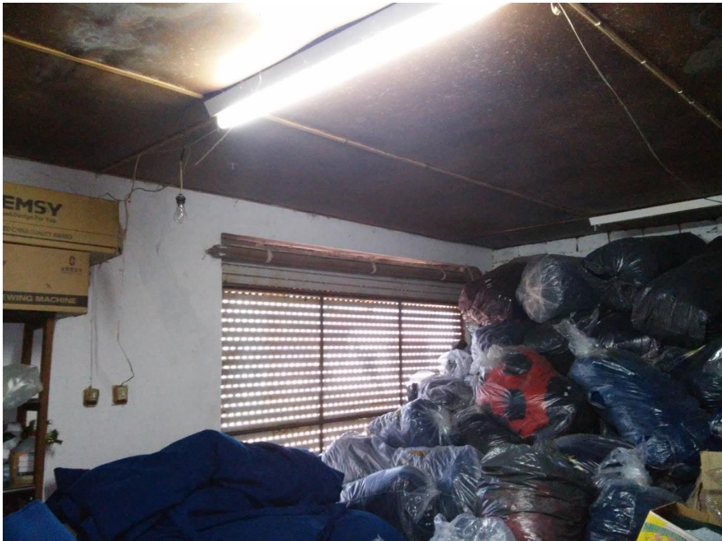
Foto 4: deposito de prendas sin orden alguno y no se respeta la distancia al techo
