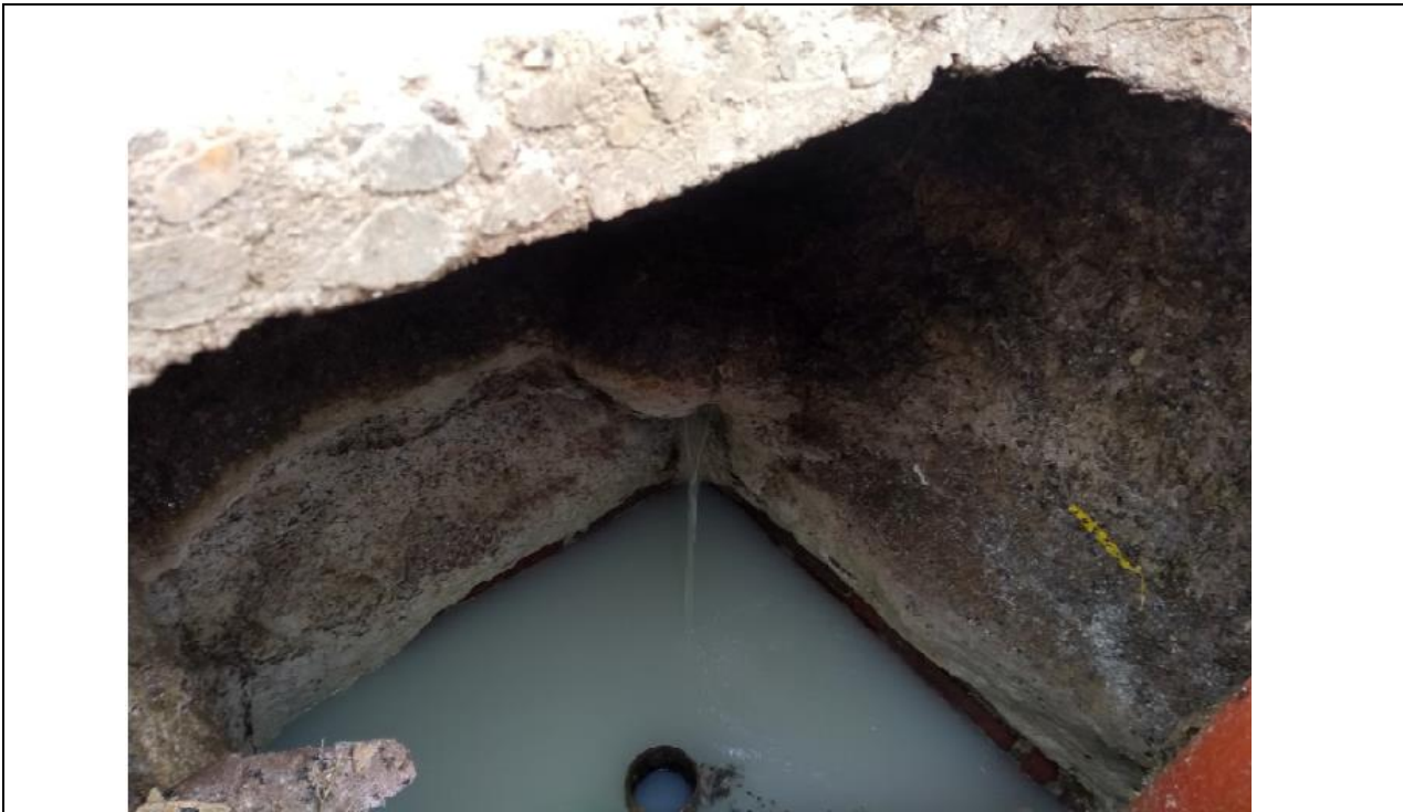
Figura 8. Pozo de bombeo.
