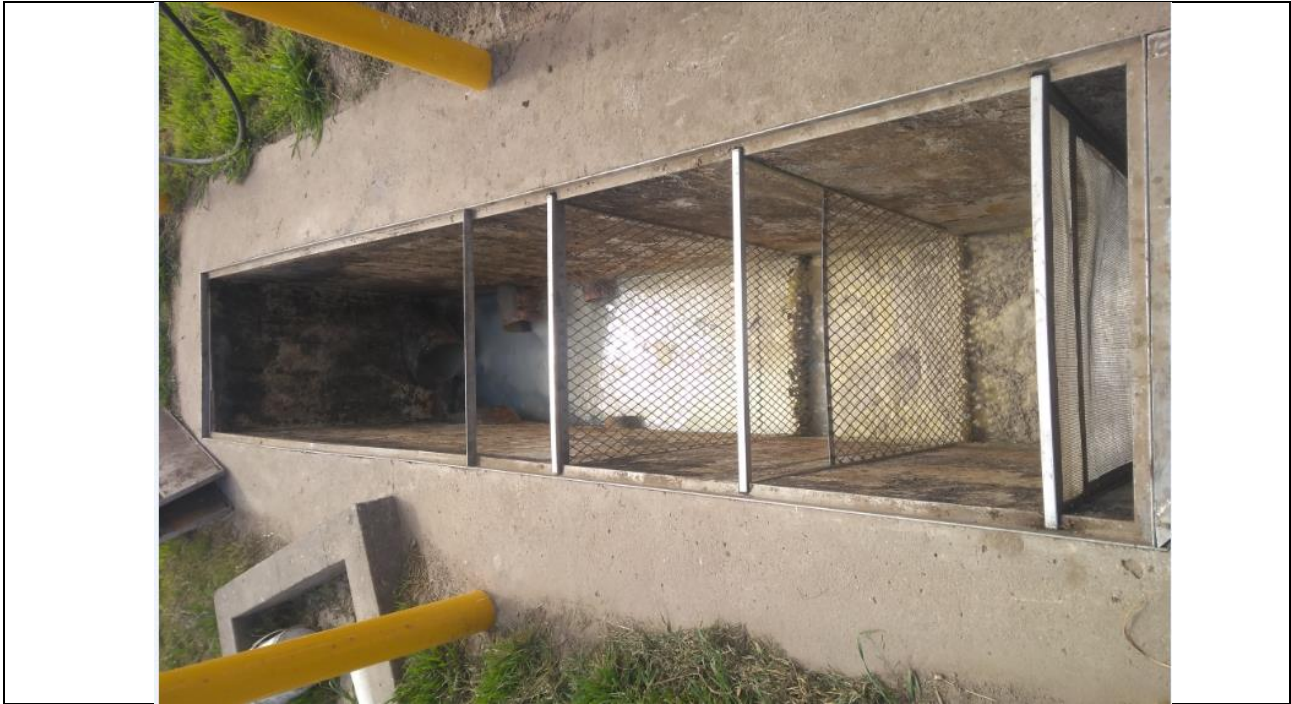
Figura 7. Vista de la camara de rejas lateral.
