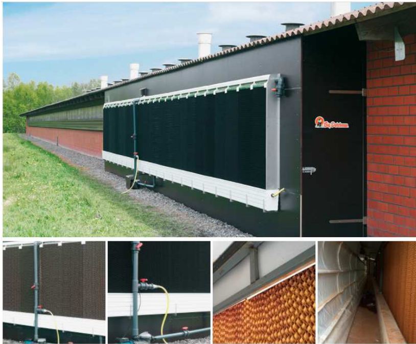
Imagen 4: Implementación de Paneles Evaporativos en criaderos de pollos.
