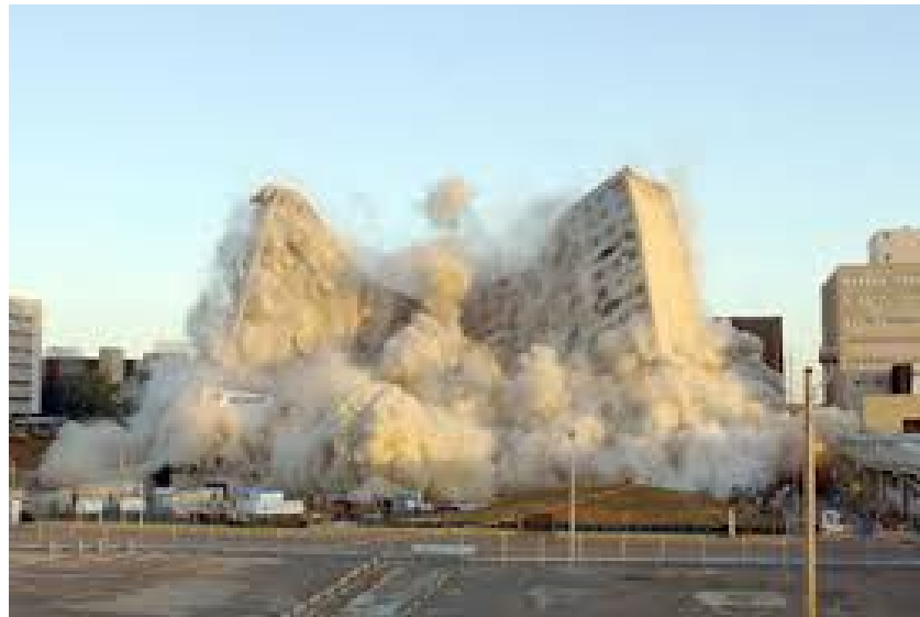
Fig. 6-46 Implosión realizada en un edificio. [J-46]
