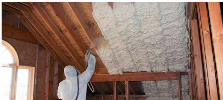
Fig. 6-43 Aislación térmica de techo mediante espuma de poliuretano. [I-43]
