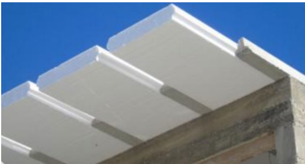
Fig. 11-43 Foto de losa con viguetas. Adaptado de [M-43]
