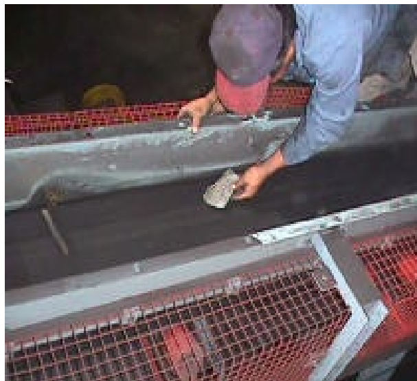
Fig. 9 Elaboración y la instalación de las placas helicoidales.
