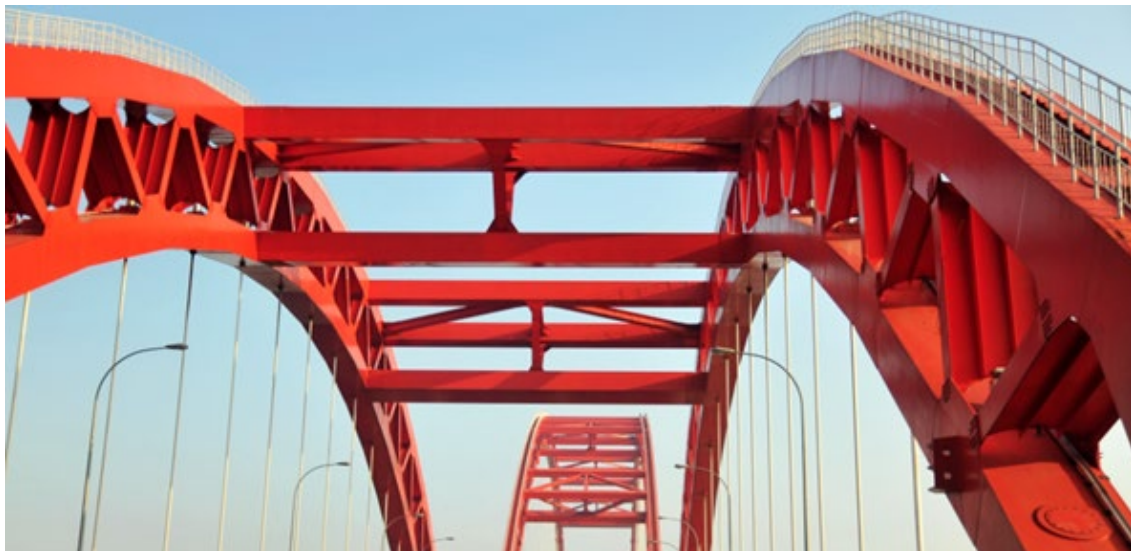
Fig. 2-50 Pintura protectora para estructuras en ambientes marinos. [D-50]
