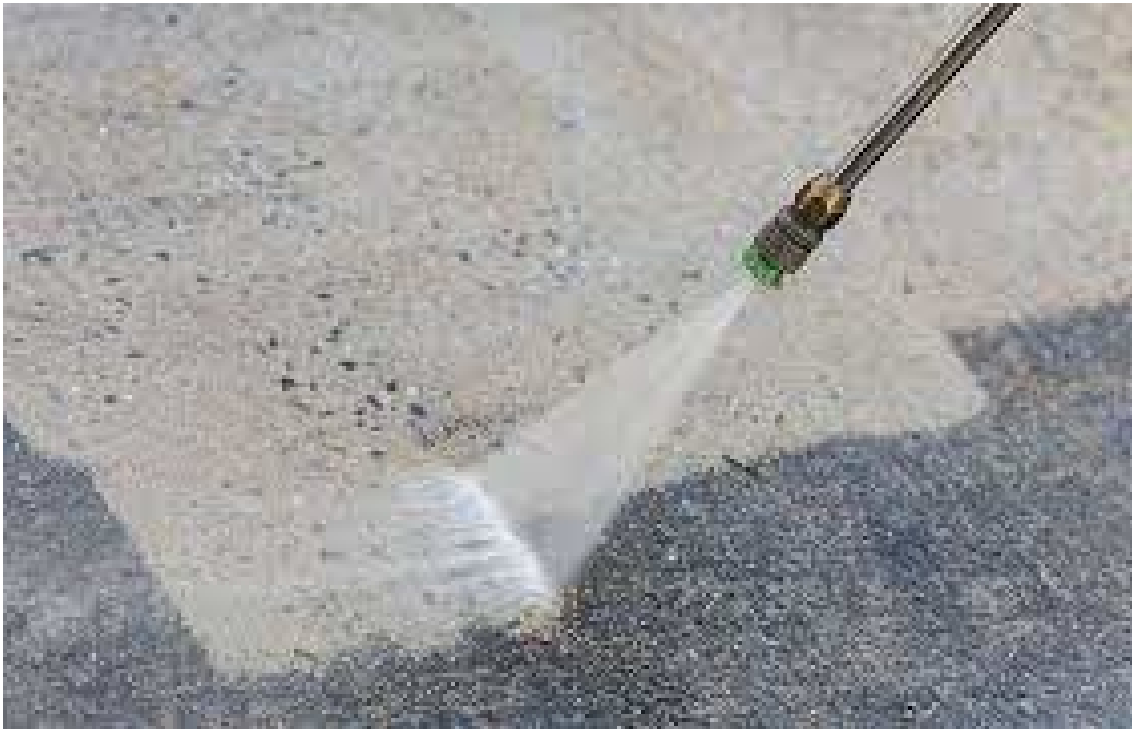
Fig. 2-43 Limpieza de un depósito de almacenamiento. [E-43]
