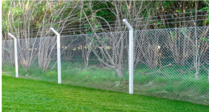
Figura 86: ilustración del cerco perimetral
