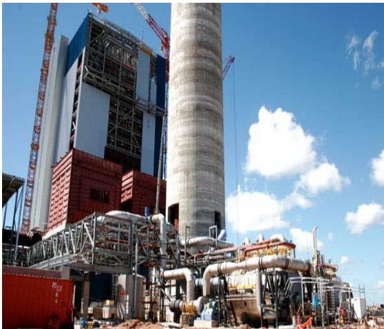
Caldera en construcción
