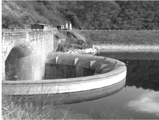
*Fig. 7.21. Imagen de aliviadero tipo pozo, central El Cadillal.*
