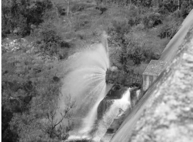
Fig. 7.30. Chorro de agua formado por la válvula de "Chorro Hueco".
