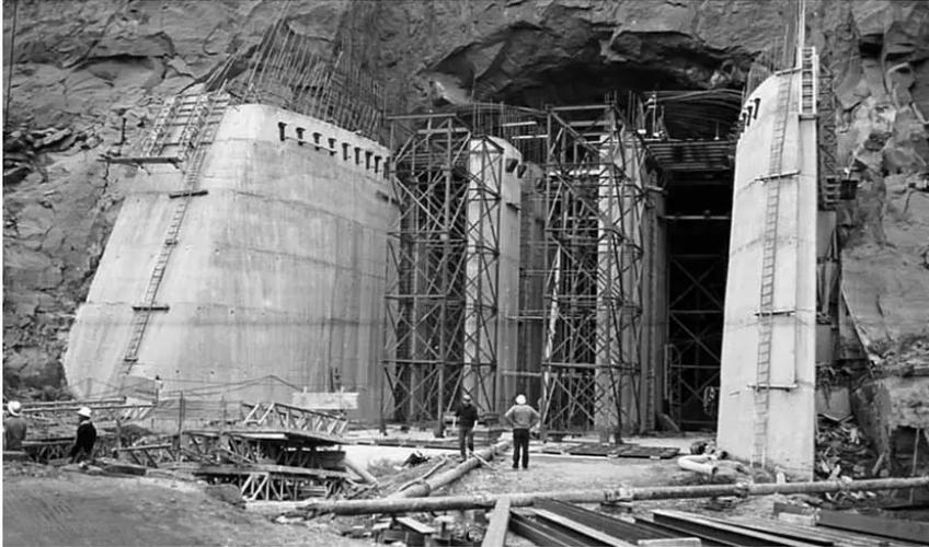
Fig. 2.3. Construcción de túneles de la central hidroeléctrica El Chocón<sup>14</sup>.
