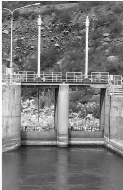
*Fig. 7.22. Imagen de compuerta deslizante.*
