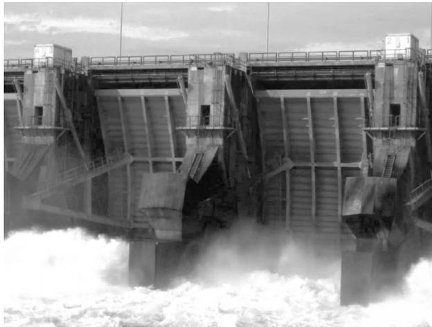
*Fig. 7.23. Imagen de compuerta radial.*
