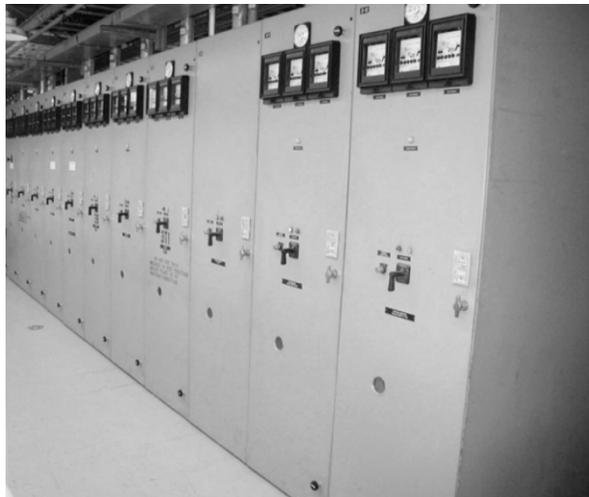
*Fig. 6.38. Ejemplo de celdas de M.T.*
