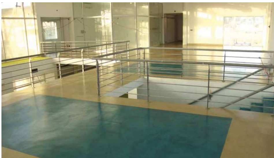
FIGURA 5.145 SISTEMA DE PISO CEMENTICIO.
