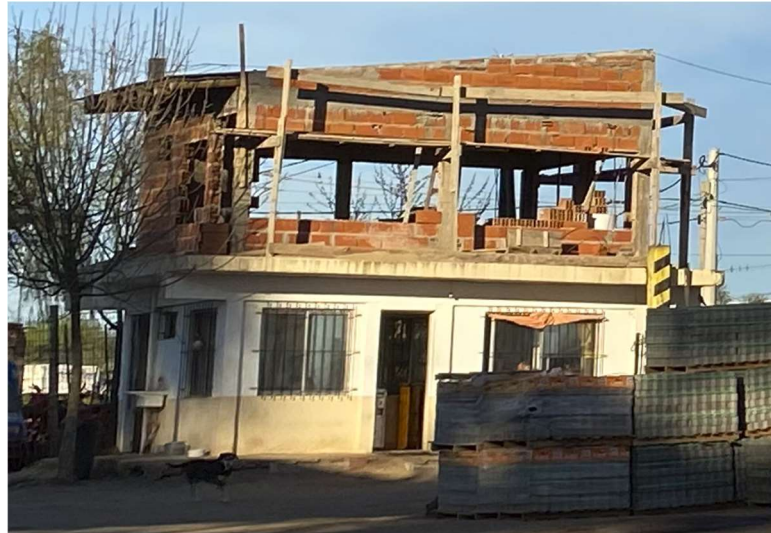
FIGURA 4.49 OFICINA EN CONSTRUCCIÓN.
