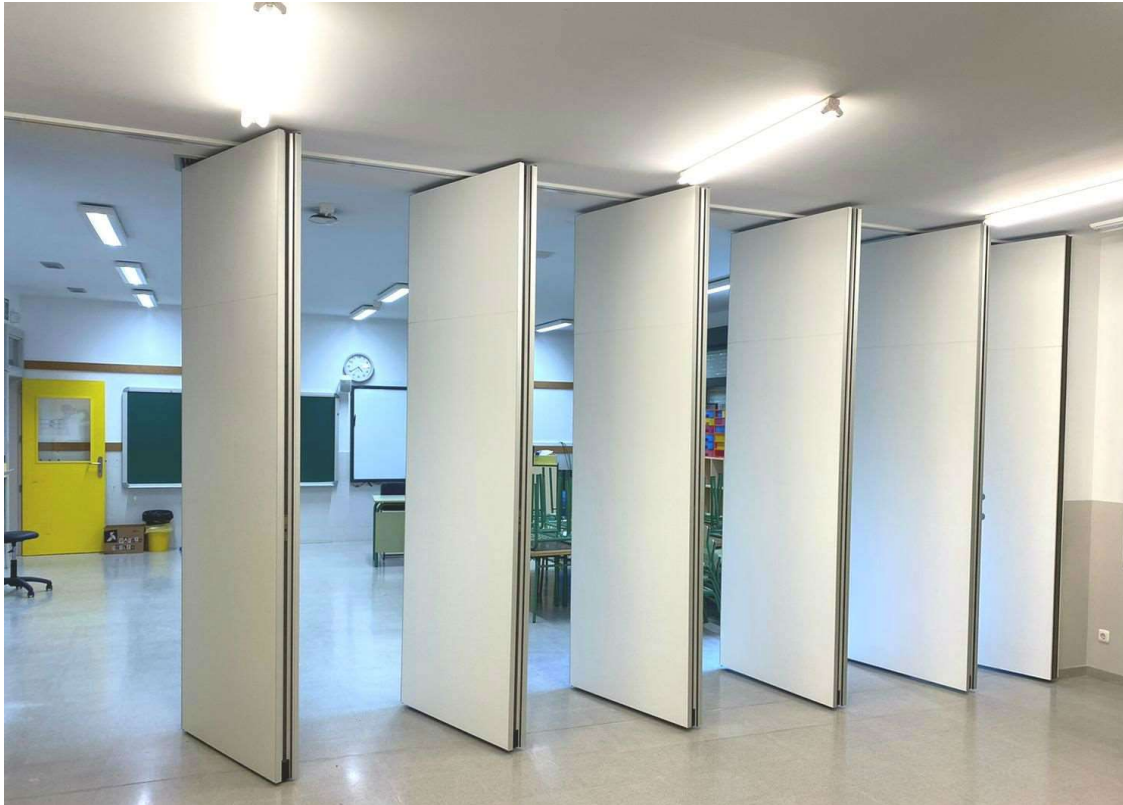
FIGURA 5.73 TABIQUE MÓVIL ACÚSTICO.
