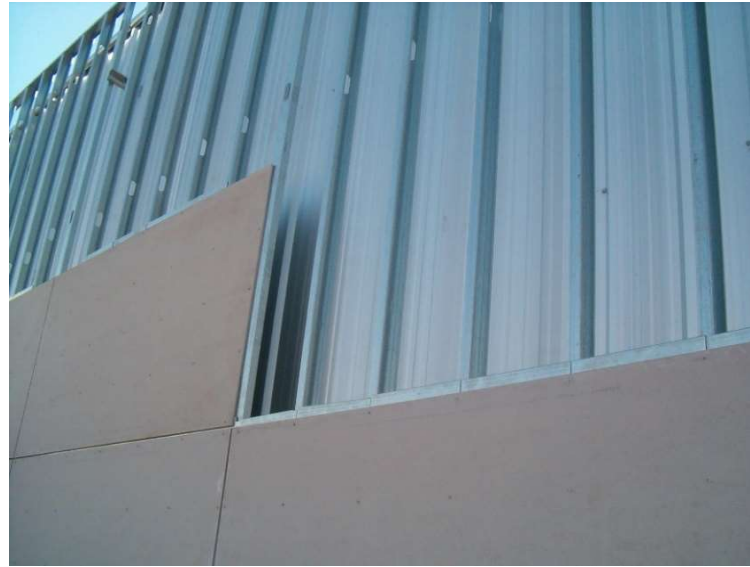
FIGURA 5.142 CERRAMIENTO DE NAVE INDUSTRIAL.
