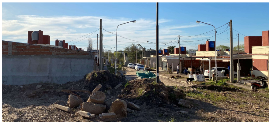
FIGURA 4.52 FALTA DE CERRAMIENTO.
