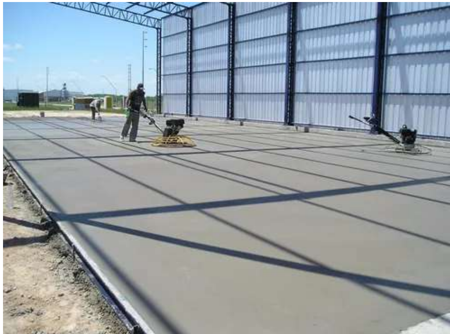
FIGURA 5.124 PISO NAVE DE ESTACIONAMIENTO.
