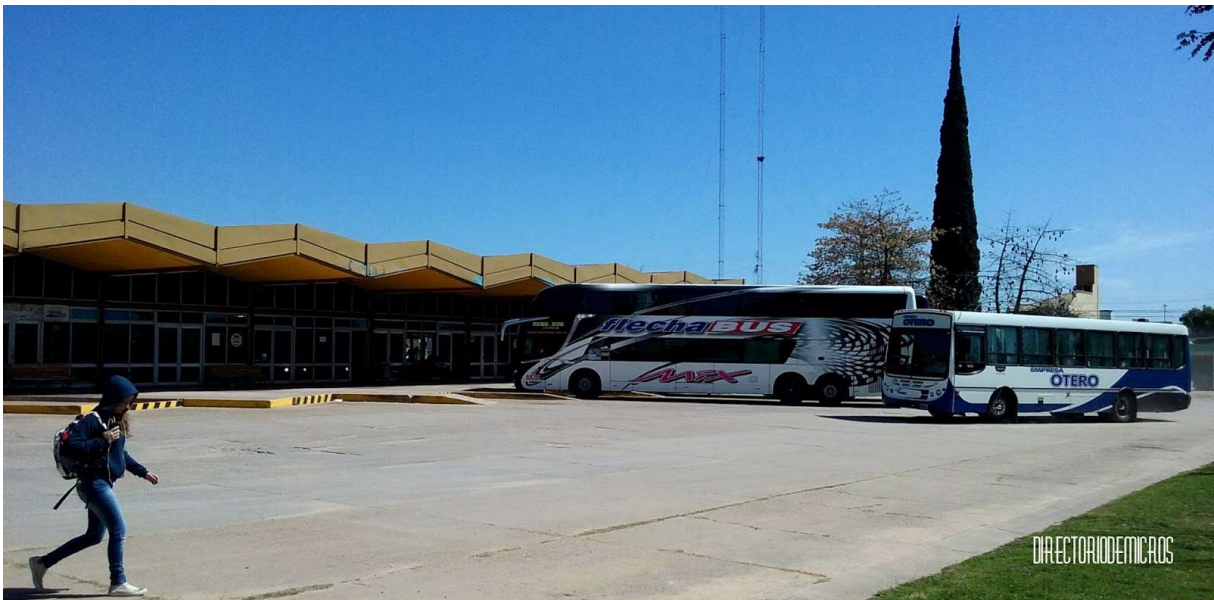
FIGURA 2.11 TERMINAL DE ÓMNIBUS.
