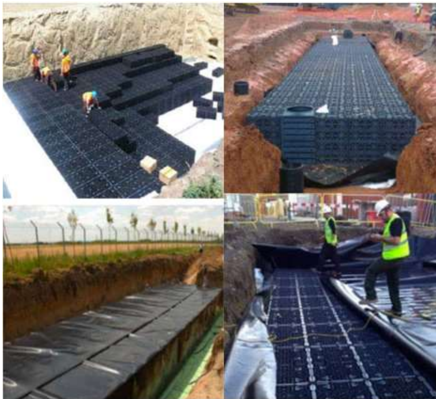
FIGURA 5.10 ECOBLOCS - SISTEMAS URBANOS DE DRENAJE SOSTENIBLE
