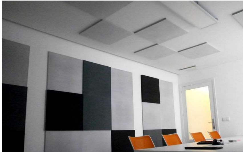
FIGURA 5.86 PANELES DECORATIVOS ACÚSTICOS.
