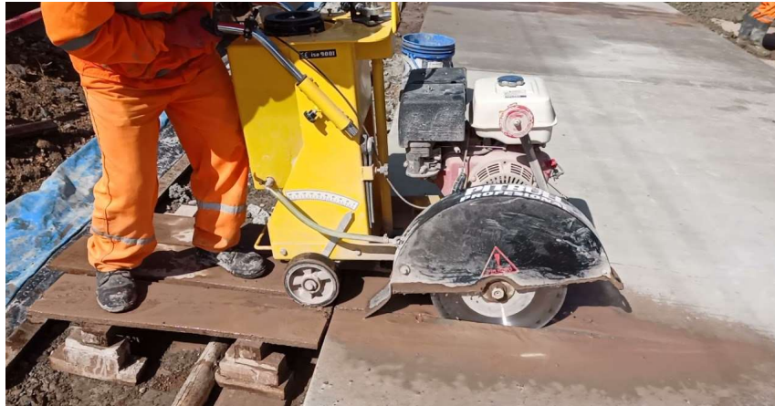
FIGURA 5.39 PROCESO DE REALIZACIÓN DE JUNTA TRANSVERSAL.
