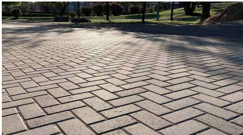
FIGURA 5.27 ADOQUINES DE HORMIGÓN TIPO H COLOCADOS EN PATRÓN "ESPINA DE PEZ".
