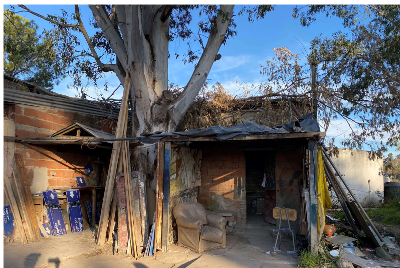
FIGURA 4.54 EDIFICACIÓN PRECARIA – ÁREA DE BACHEO
