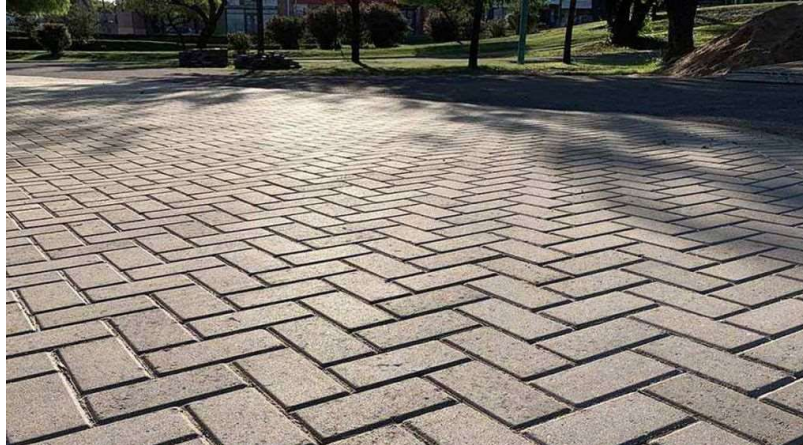
FIGURA 5.62 ADOQUINES DE HORMIGÓN TIPO H.
