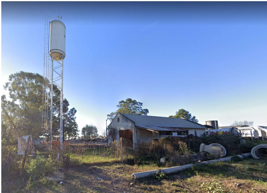
FIGURA 4.41 TANQUE ELEVADO DE AGUA POTABLE.
