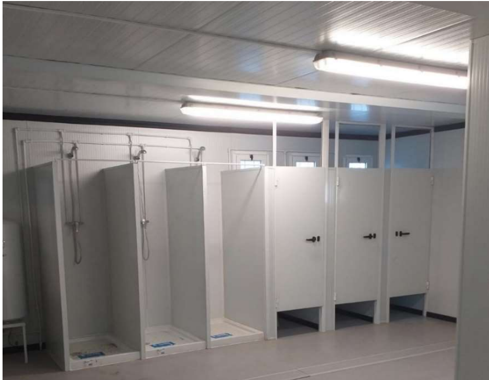
FIGURA 5.88 VESTUARIO CON CIELORRASO DE PVC.
