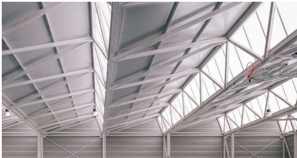
FIGURA 5.143 CUBIERTA TIPO DIENTE DE SIERRA.
