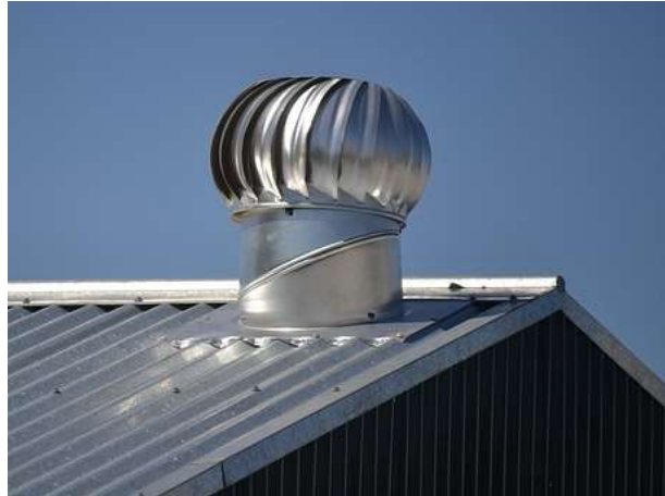
FIGURA 5.144 EXTRACTOR EÓLICO.
