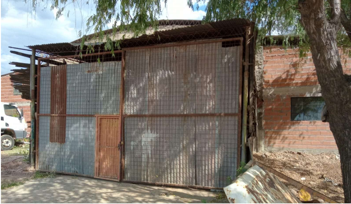
FIGURA 4.55 ÁREA DE PINTURA VEHICULAR.
