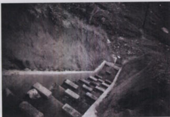
Figura 71a –Imagen dissipador de energía
