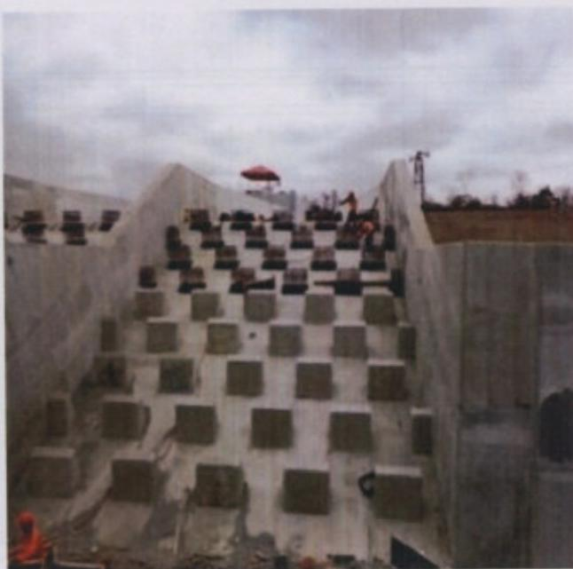
Figura 71b –Imagen dissipador de energía
