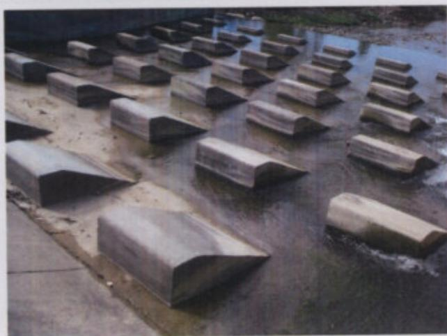
Figura 71c –Imagen dissipador de energía
