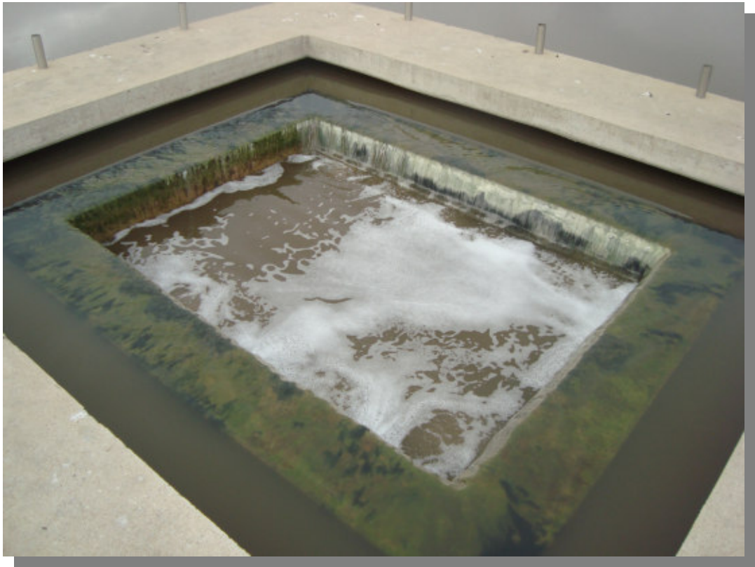
Paso de agua de lagunas por diferencia de nivel
