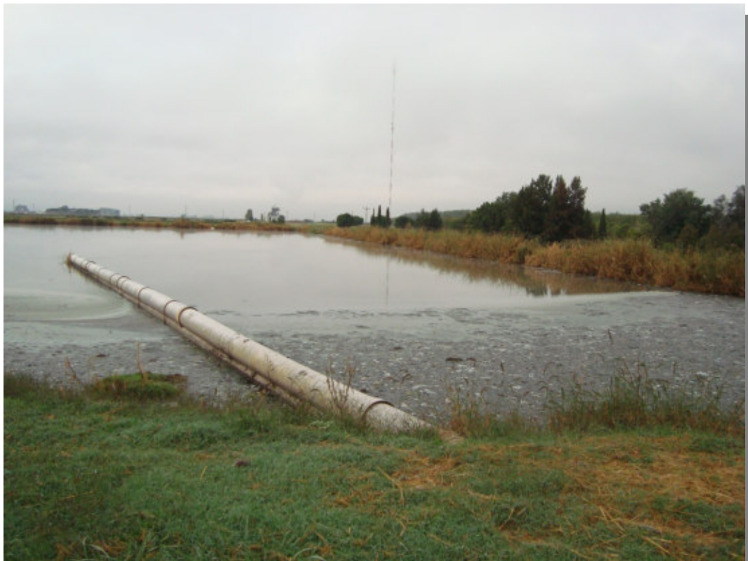
Laguna anaeróbica
