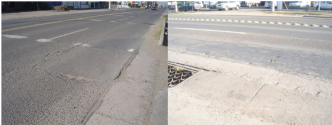
Figura 9 – Ahuellamiento
