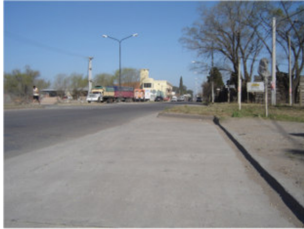
Foto 2- Reducción de calzada para protección de estacionamientos.
