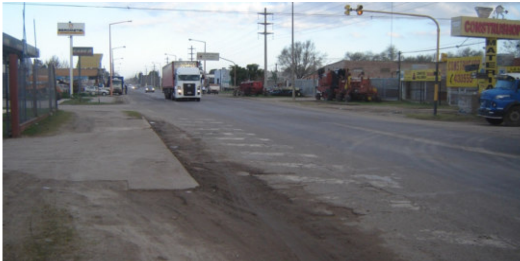
Foto 2 – Reducción de la cantidad de carriles en intersección de Ruta 8 y Dimmer.
