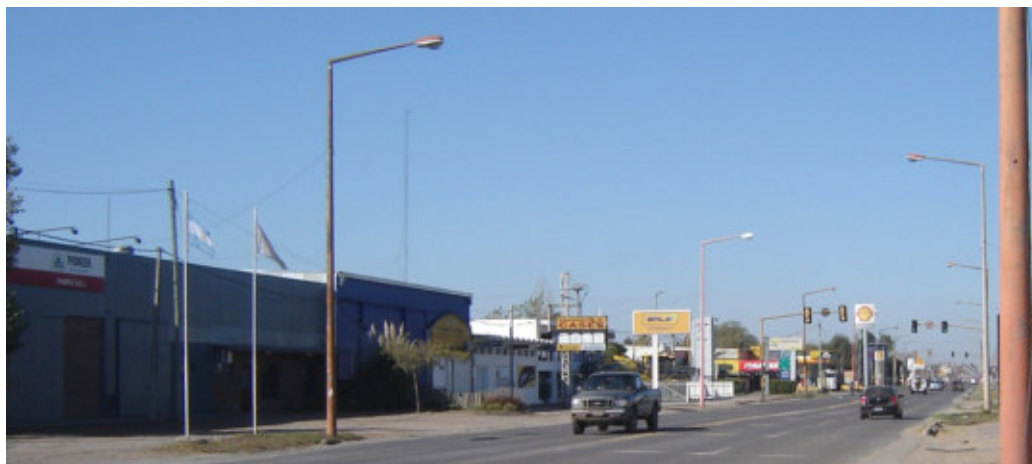
Foto 13 – Vista de parte del alumbrado público.
