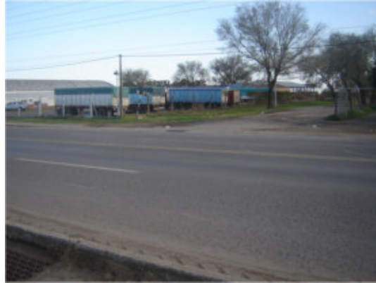
Figura 5 - Peladuras de baja severidad
