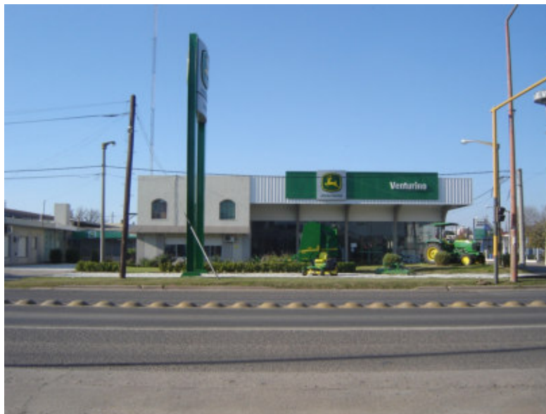
Foto 1 – Separador de carriles mediante tortugones entre Hipólito Yrigoyen y 9 de Julio.
