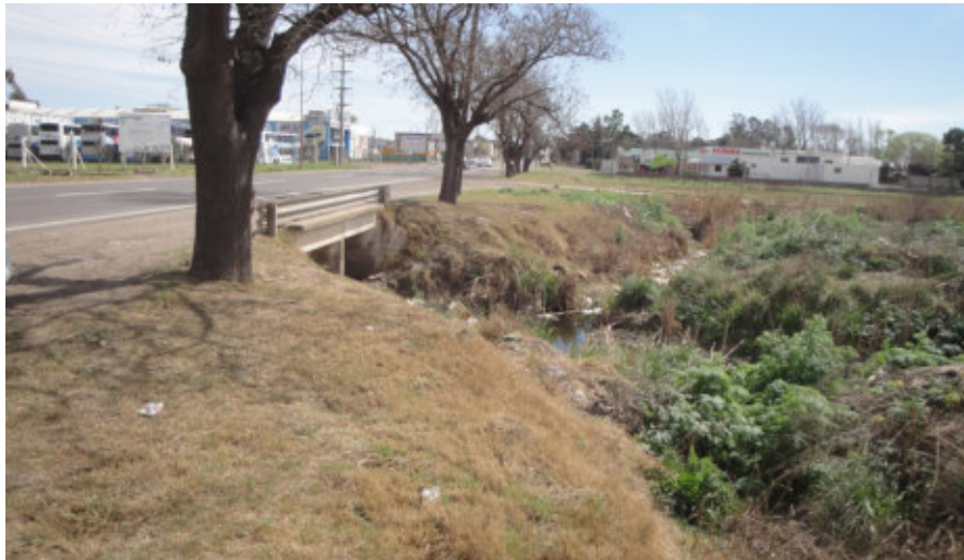
Foto 6 – Alcantarilla rectangular zona A.Re.N.
