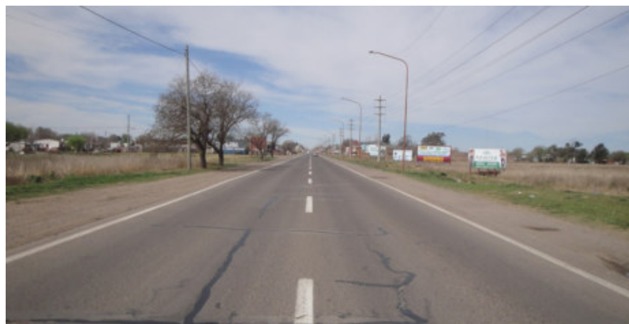
Foto 5 – Intersección Ruta 8 con A.Re.N. (Vista a Sureste).
