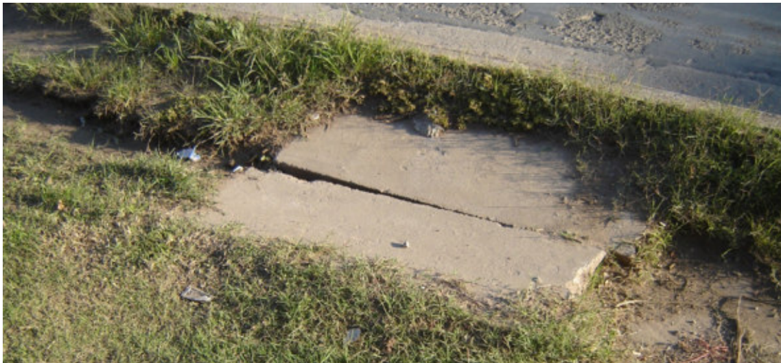
Foto 9 – Cámara de inspección.
