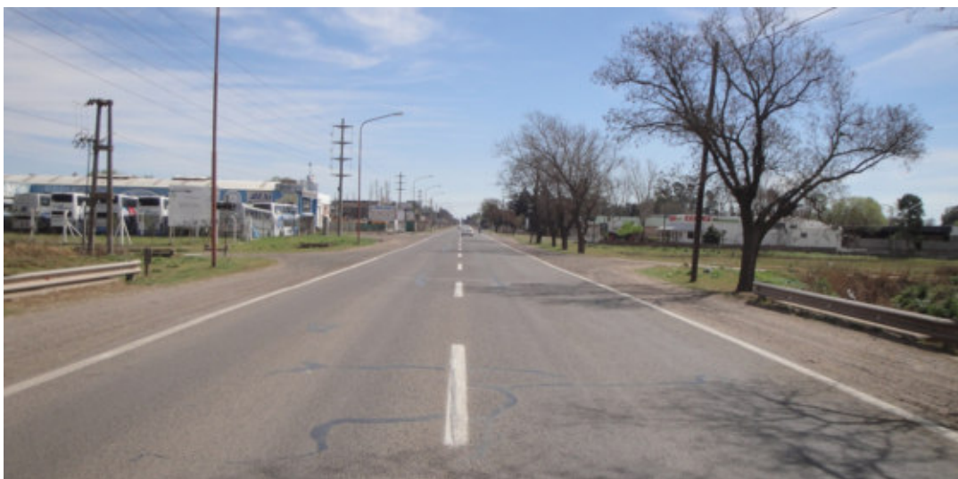
Foto 4 – Intersección Ruta 8 con A.Re.N. (Vista a Noroeste).
