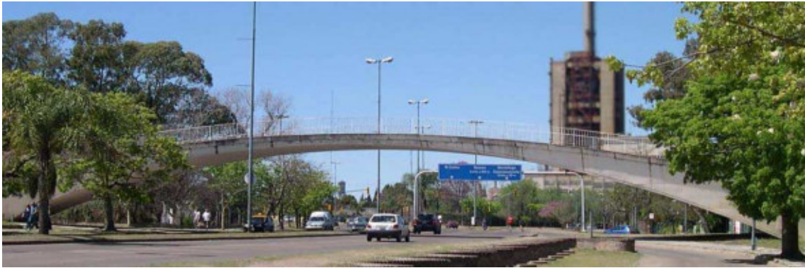
sarela Peatonal sobre Av. Frondizi, Rosario.
