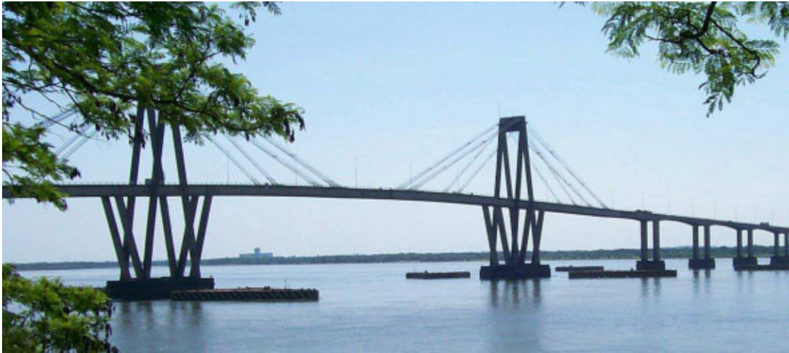
Figura 61 – Puente Atirantado: Chaco-Corrientes (Pte Gral. Belgrano)
