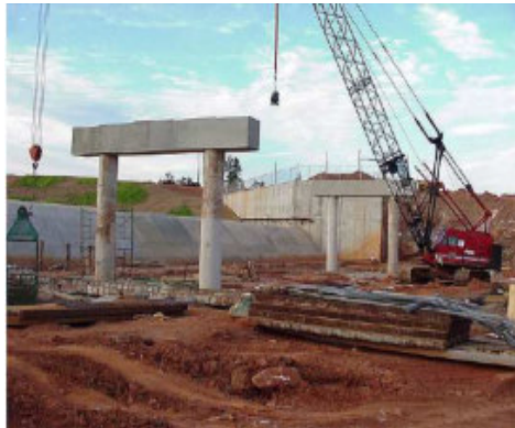
Figura 120 – Viga de Pórtico y Pilas.
