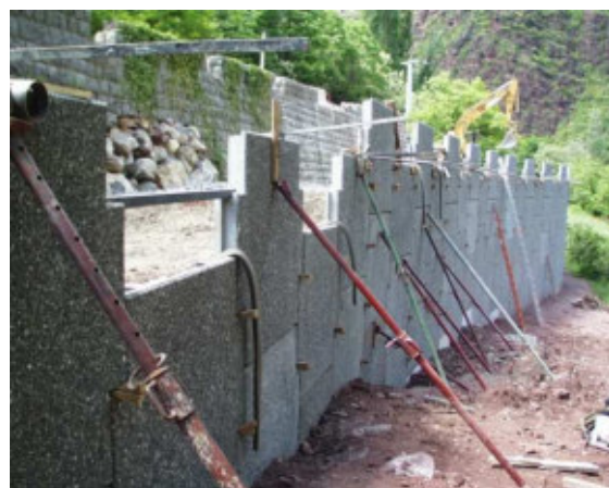
Figura 133 – Puesta en obra.
