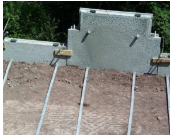
Figura 132 – Puesta en obra.
