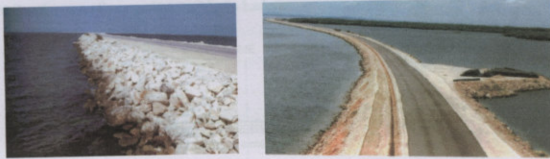
Figura 11.1 Escollera o coraza del pedraplén Foto 11.1.1 Vista de un pedraplén con finalidad vial
