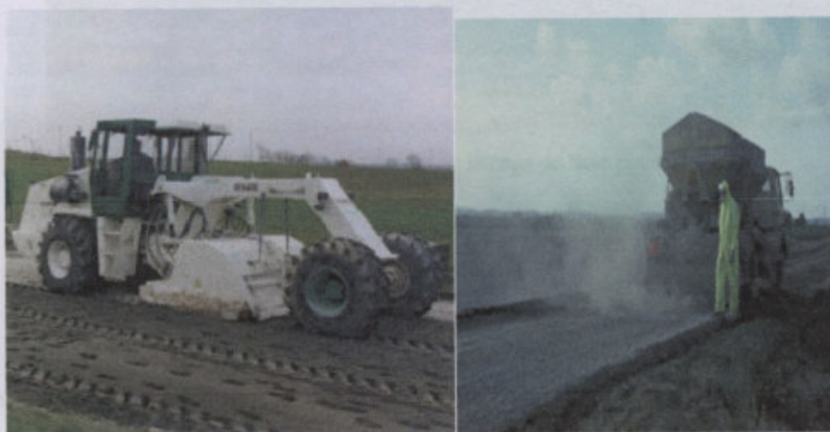
Fig. 7.1.2.3 - Equipos Mezcladores de materiales y suelo
