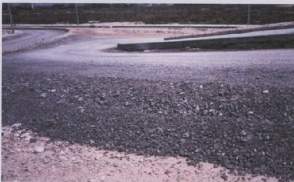
Fig. 7.1.2.3.a – Aspecto de la capa de base puesta en obra
