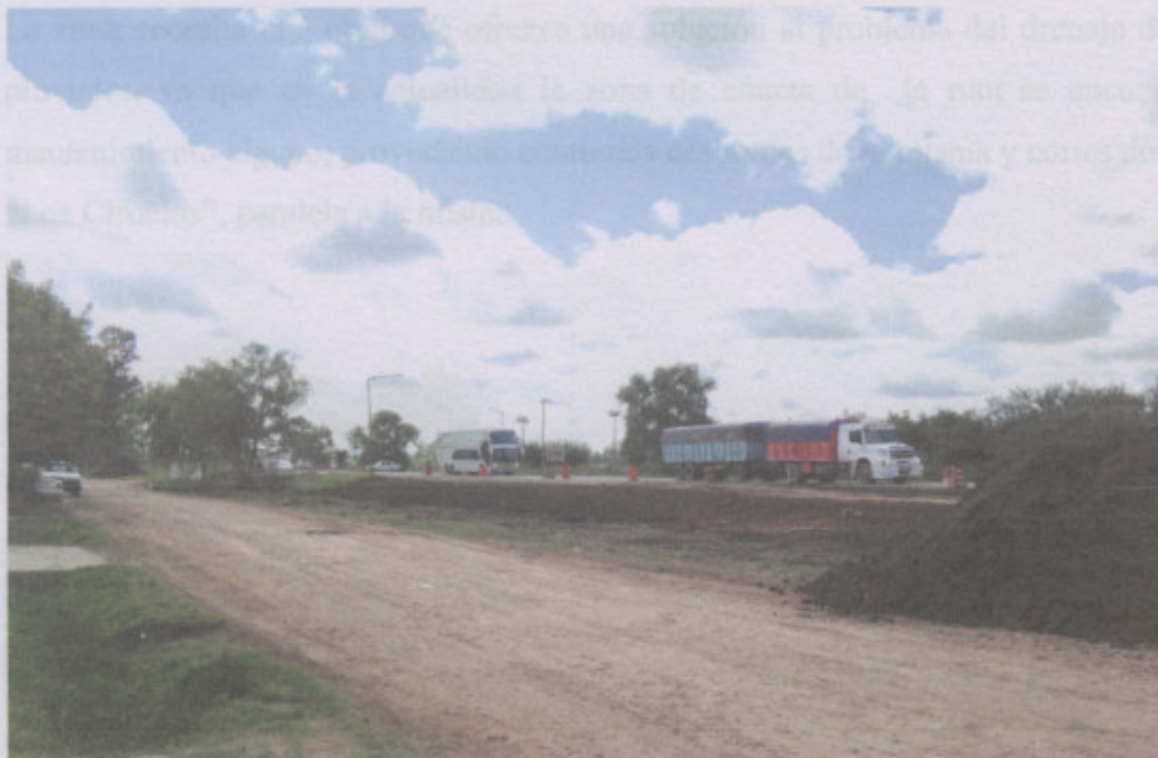
Tránsito sobre la RN N°33, a la izquierda, calle paralela del Barrio Santa Rosa, "Los Ciruelos"
