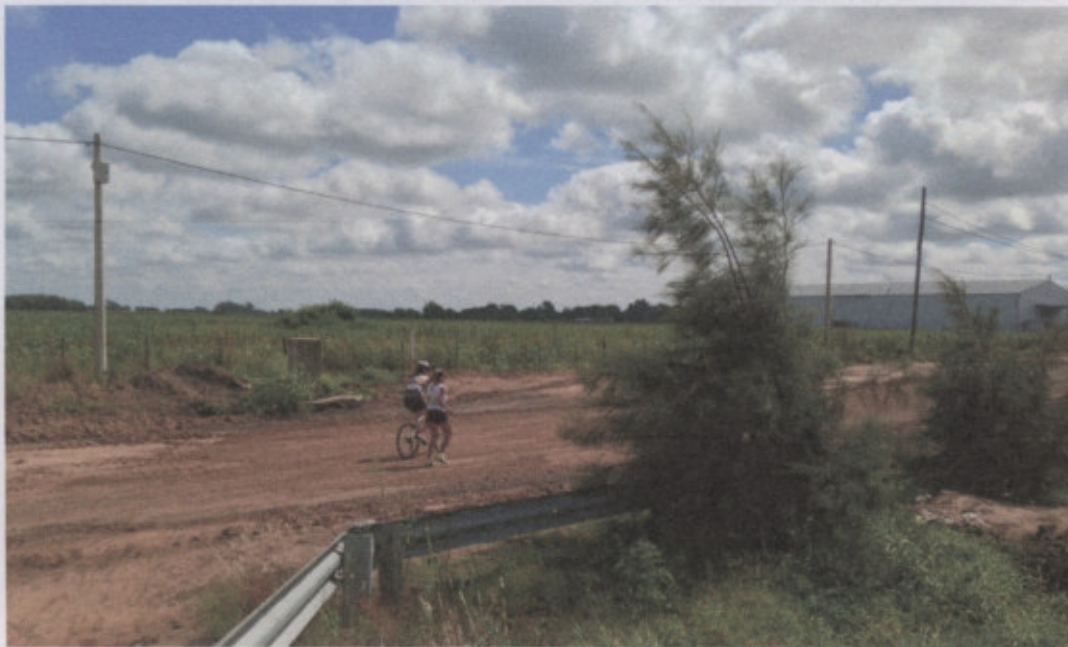
Calle "Los Ciruelos" altura Av. Chapuis (progresiva 750)
