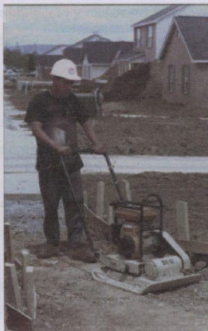
Compactador tipo bandeja vibratoria
