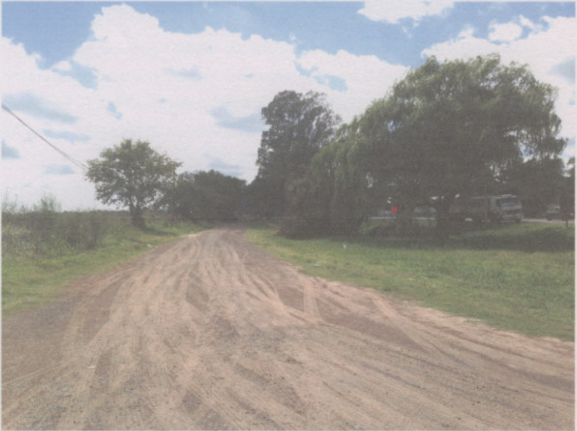
Calle "los Ciruelos" en zona rotonda RN N°33 y RN N°8, (Progresiva 0). Estado actual
