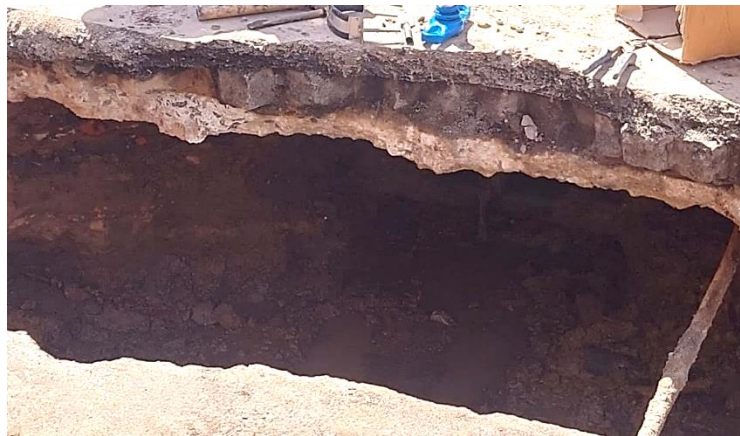
Figura 24. Adoquines debajo de pavimento flexible.
