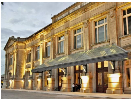
Figura 7. Centro de Convenciones Estación Belgrano
