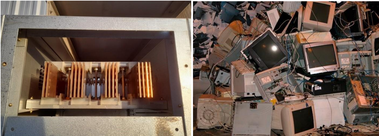
Foto del autor cobre electrolítico puro de barras eléctricas. Derecha: acopio poco apropiado de RAEE.
