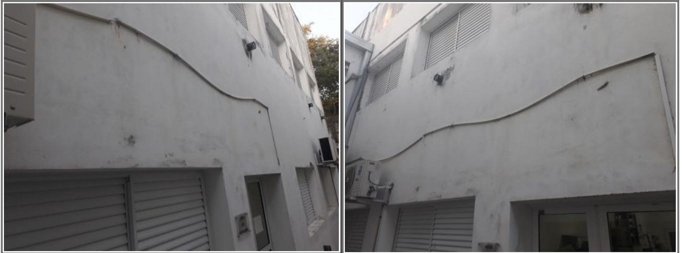
Tendido exterior que conectaba dos direcciones, como se observa en muy mal estado.
