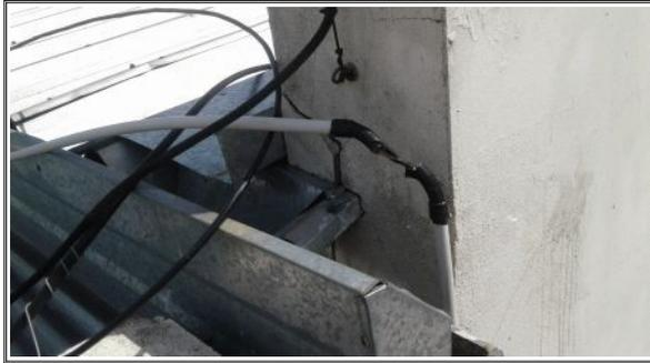
Detalle de cableado exterior con caño plástico totalmente deteriorado
