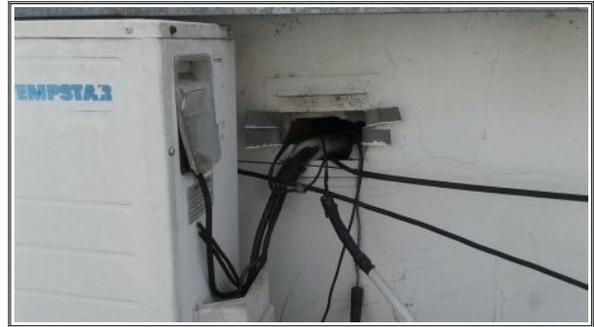
Acceso de cableado al edificio a través de una rejilla de ventilación junto con electricidad y aire acondicionado
