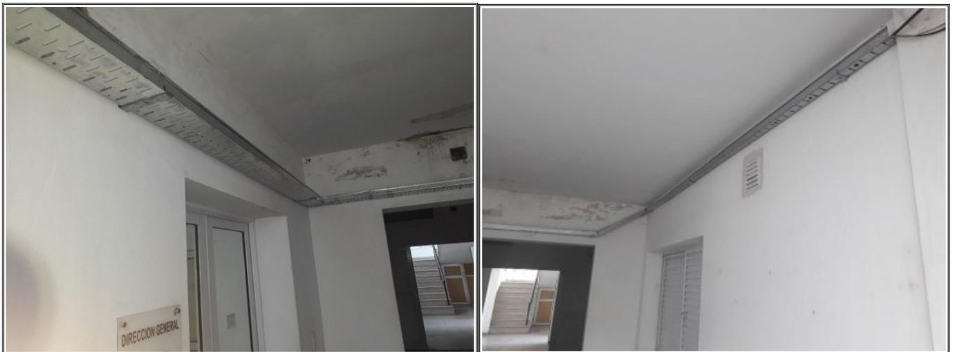
Bandejas instaladas para reemplazar el tendido por el exterior mostrado mas arriba.
