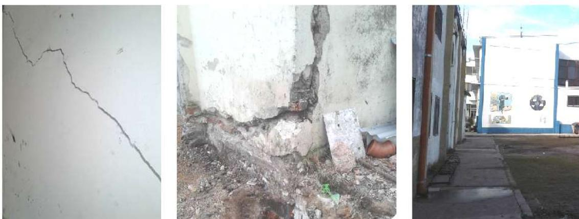
**Figura 2.6. Izq.: Fisuras a 45° en muros. Centro: Grietas en esquinas. Der.: Rotura de veredas.**
