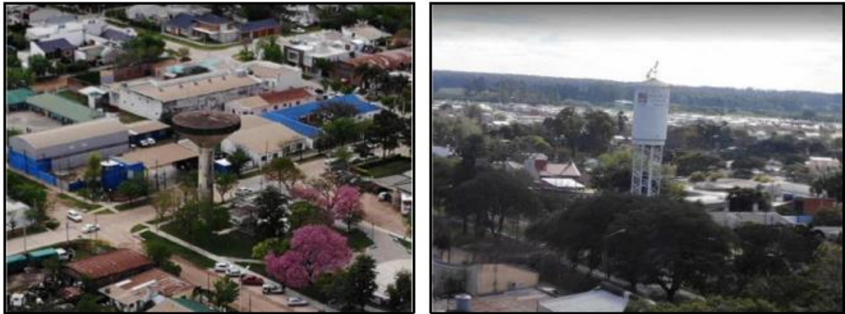
Figura 2-34. Tanques elevados de agua potable. Fuente: Google Maps.
