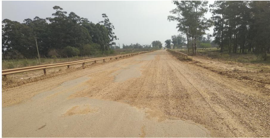
Figura 4-9. Puente sobre Ruta Tres Hermanas. Fuente: Autoría propia
