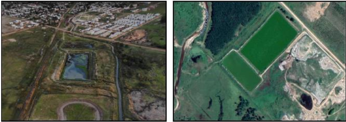
Figura 2-35. Colectora este (derecha) y oeste (izquierda). Fuente: Google Maps.
