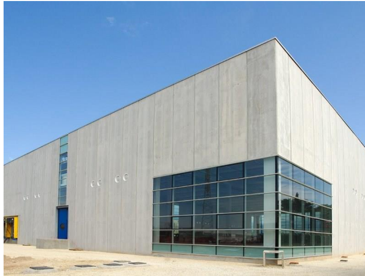
Figura 8-9. Fachada a con paneles de hormigón en cerramiento flotante.
