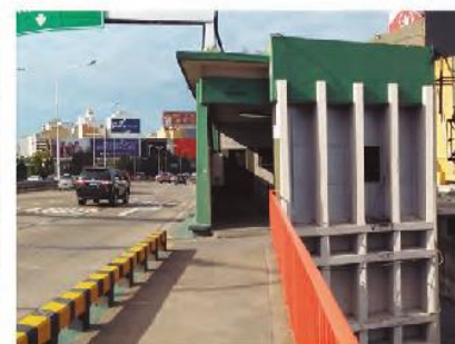
Archivo ACUMAR - 24 de Abril de 2017 Vista desde: Acceso del nivel superior
