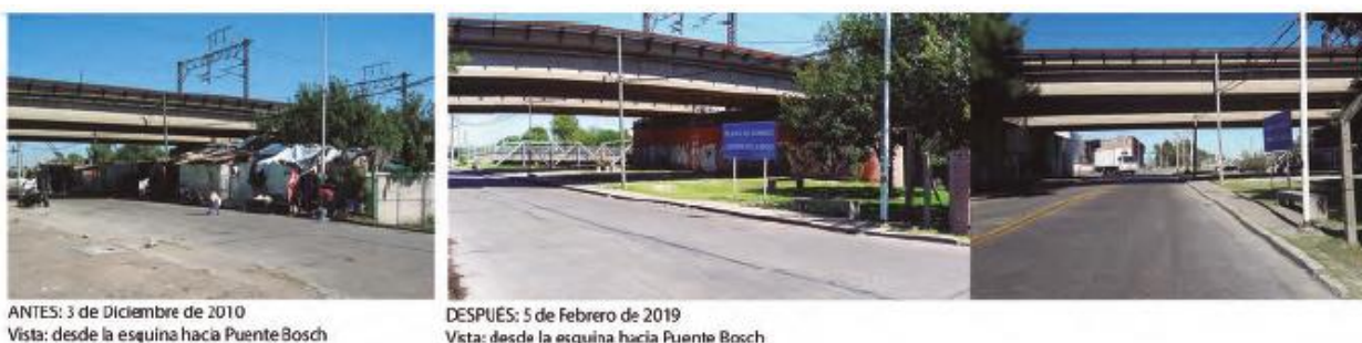
Figura 29. Bajo Puente Bosch (Avellaneda). (Fuente: Cuadernillo Recorrido Camino de Sirga. Desde Puente Transbordador Nicolás Avellaneda hasta Ruta 4. Febrero 2019 https://www.acumar.gob.ar/wp-content/uploads/2016/12/Cuadernillo-Camino-de-Sirga-Febrero-2019-1.pdf ).
