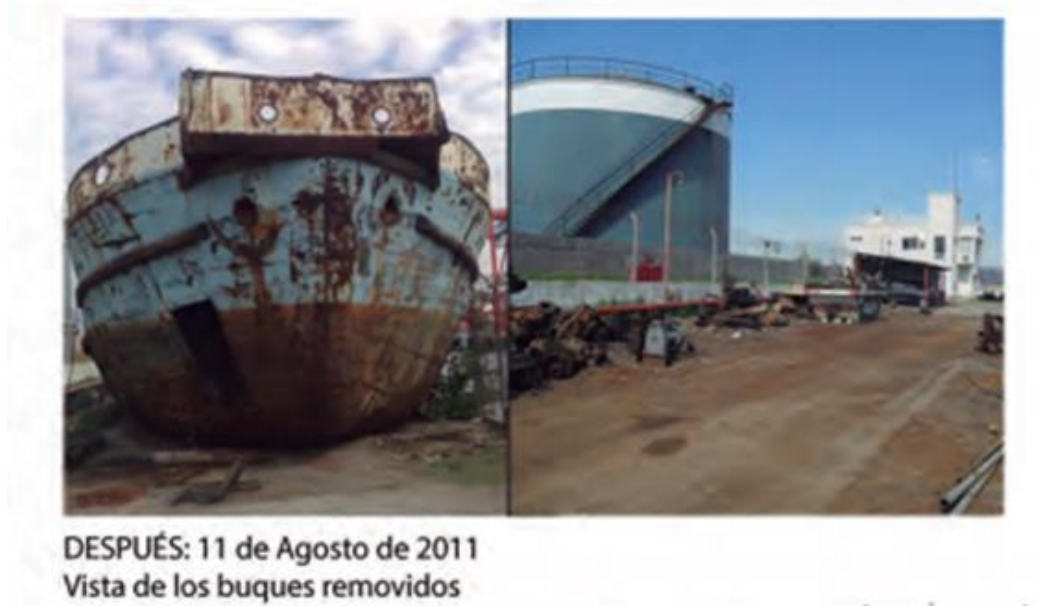
Figura 18. Remoción de buques. (Fuente: ACUMAR https://www.acumar.gob.ar/wp-content/uploads/2016/12/Cuadernillo-Camino-de-Sirga-Febrero-2019-1.pdf ).
