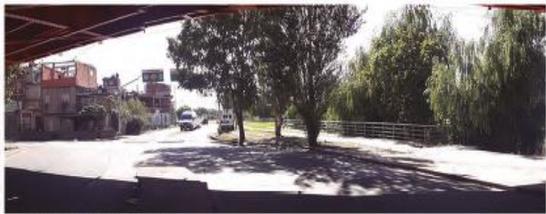
DESPUÉS: 12 de Febrero de 2019 Vista desde: Camino de Sirga hacia Desembocadura
