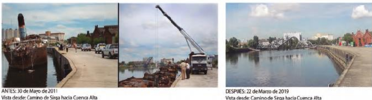
Figura 35. Remoción de buques Corcubion I y Cabo Blanco (Avellaneda). (Fuente: Cuadernillo Recorrido Camino de Sirga. Desde Puente Transbordador Nicolás Avellaneda hasta Ruta 4. Febrero 2019 https://www.acumar.gob.ar/wp-content/uploads/2016/12/Cuadernillo-Camino-de-Sirga-Febrero-2019-1.pdf ).
