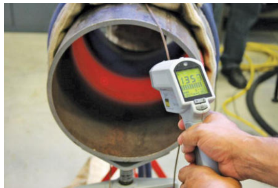
Figura 1.4 – Soldadura de caños in situ mediante inducción – Fuente: North American oil & Gas pipelines
