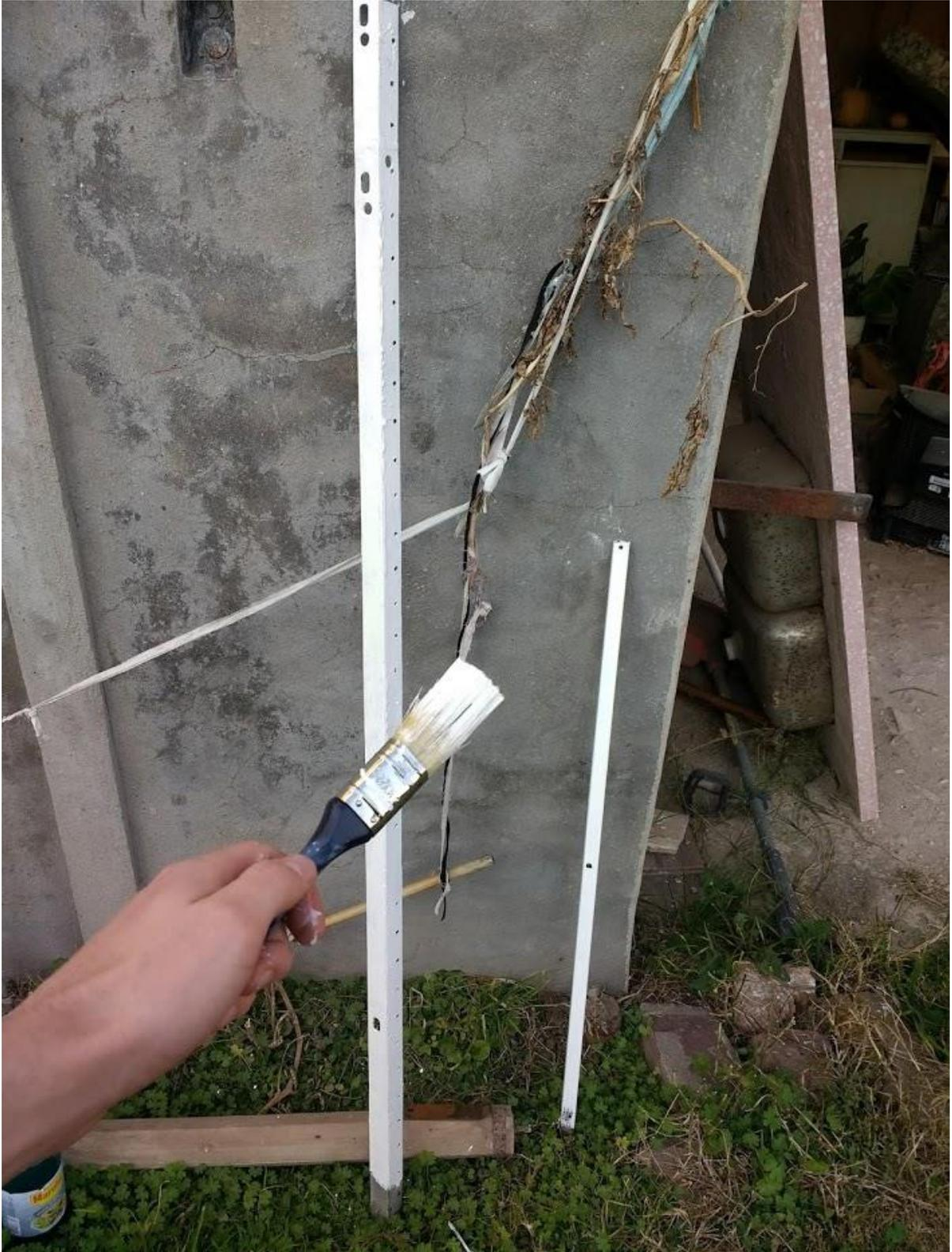
*Fig. N° 54. Proceso de pintado a la estructura de hierro del sistema.*
