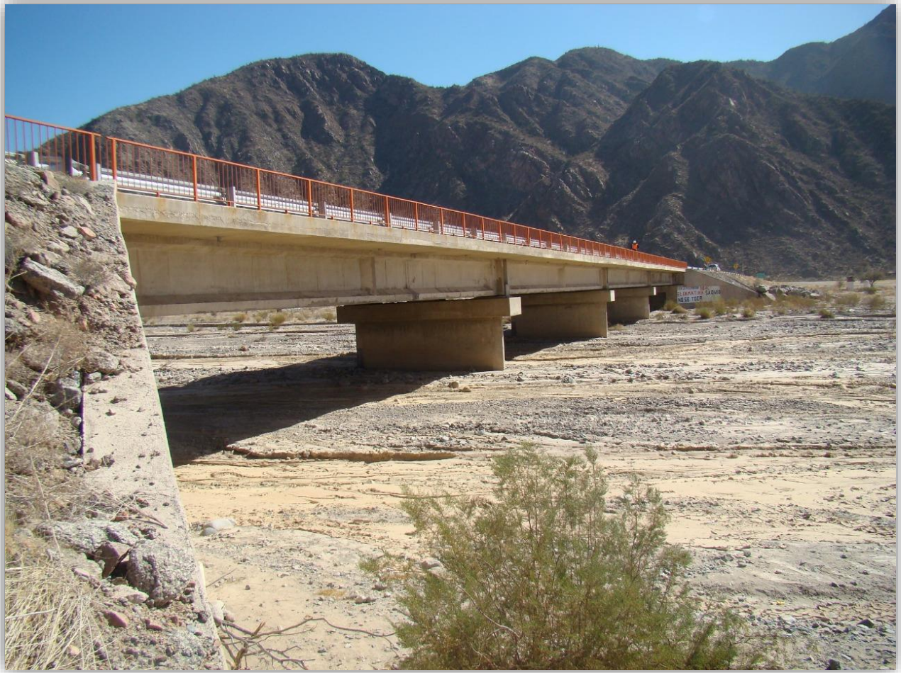
Fig. 12. Vista Puente Rio Capayan
