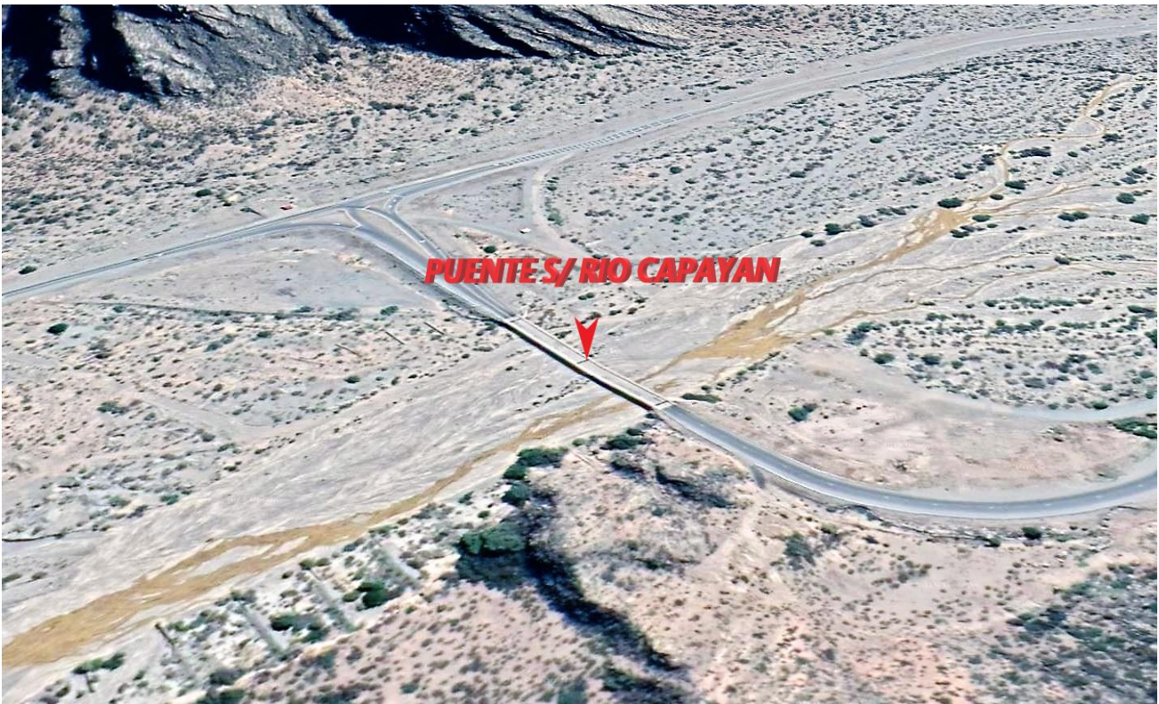
Fig. 11. Emplazamiento del puente sobre RN N°40
