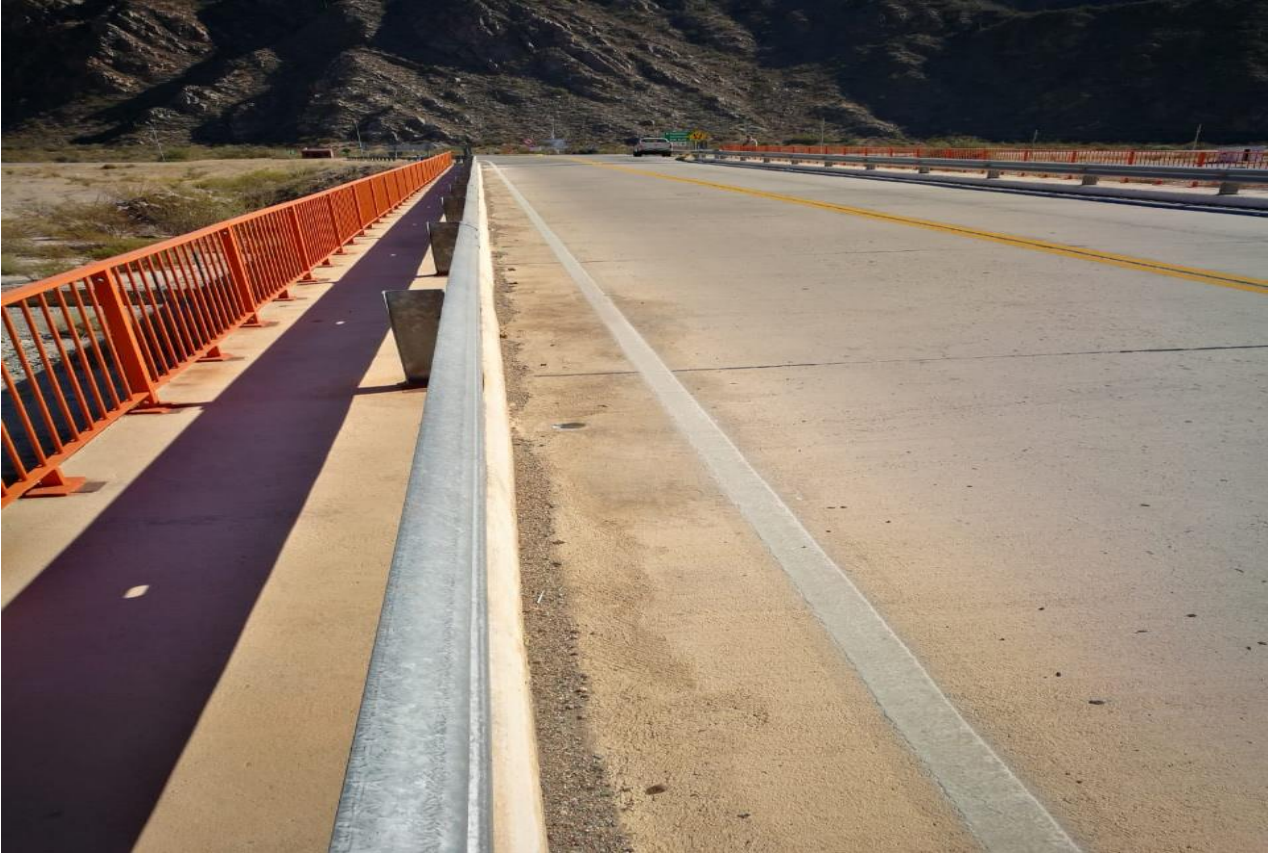
Fig. 13. Calzada del puente y veredas
