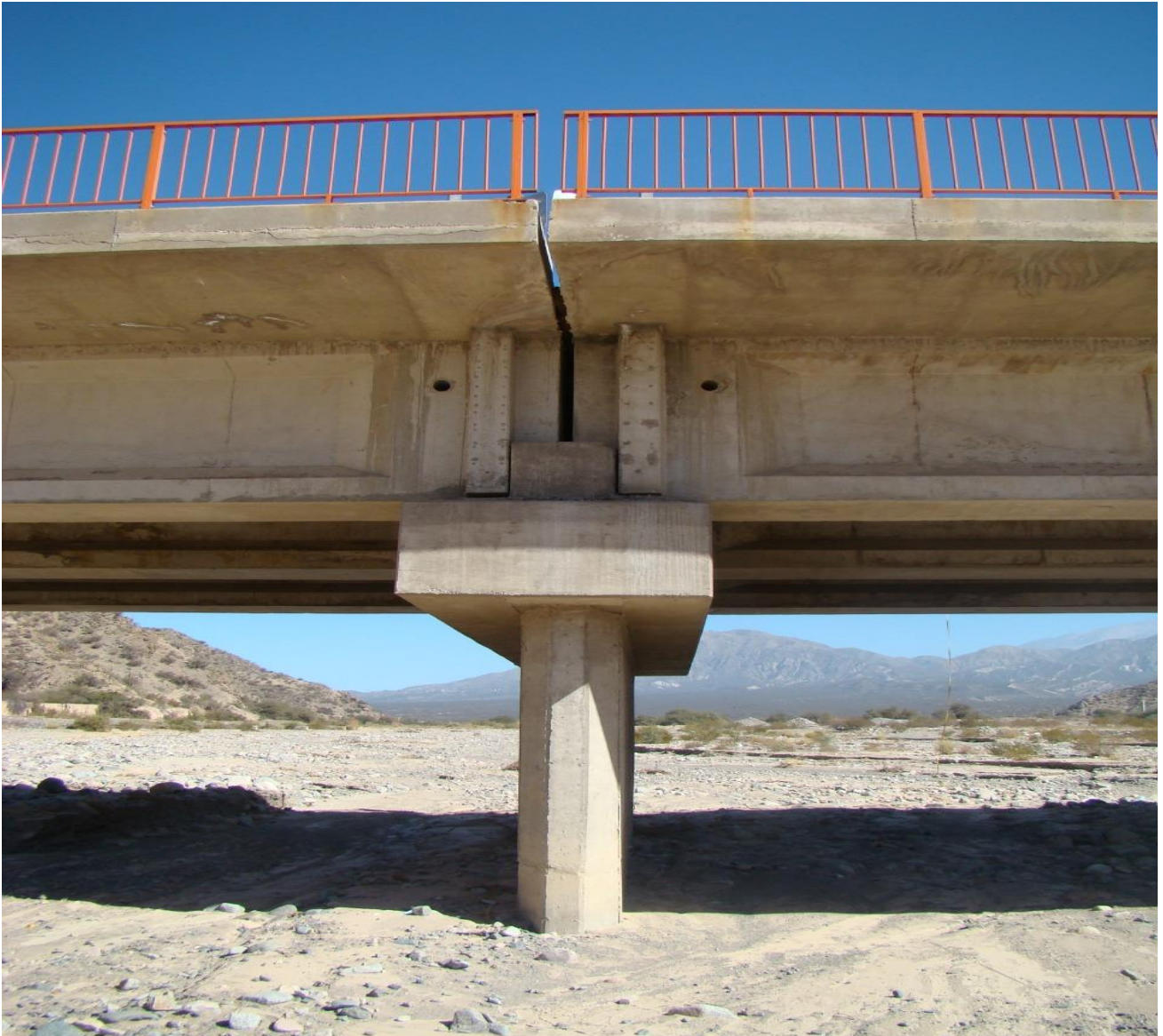
Fig. 16. Junta dilatación tipo TORMAC.
