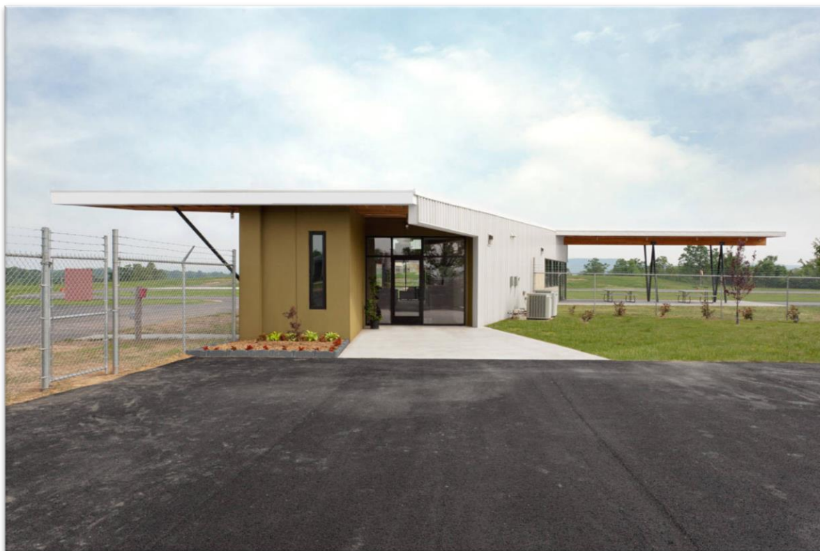
Figura 31 Aeropuerto de Carroll Berryville, Estados Unidos – Acceso. Fuente: https://www.archdaily.com/246654/carroll-county-airport-terminal-modus-studio
