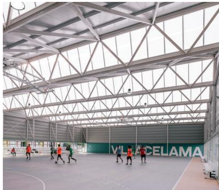
Figura 5-22: Estructuras metálicas reticuladas
