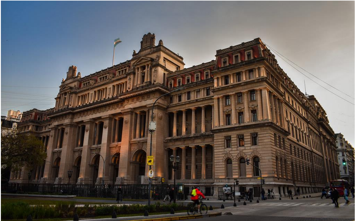
Figura 2-6: Palacio de Justicia de la Nación Argentina, de Martín Alejo Hormanstorfer. Fuente: Flickr, 2018, ( https://www.flickr.com/photos/martinhache/44263346741 ). Todos los derechos reservados.
