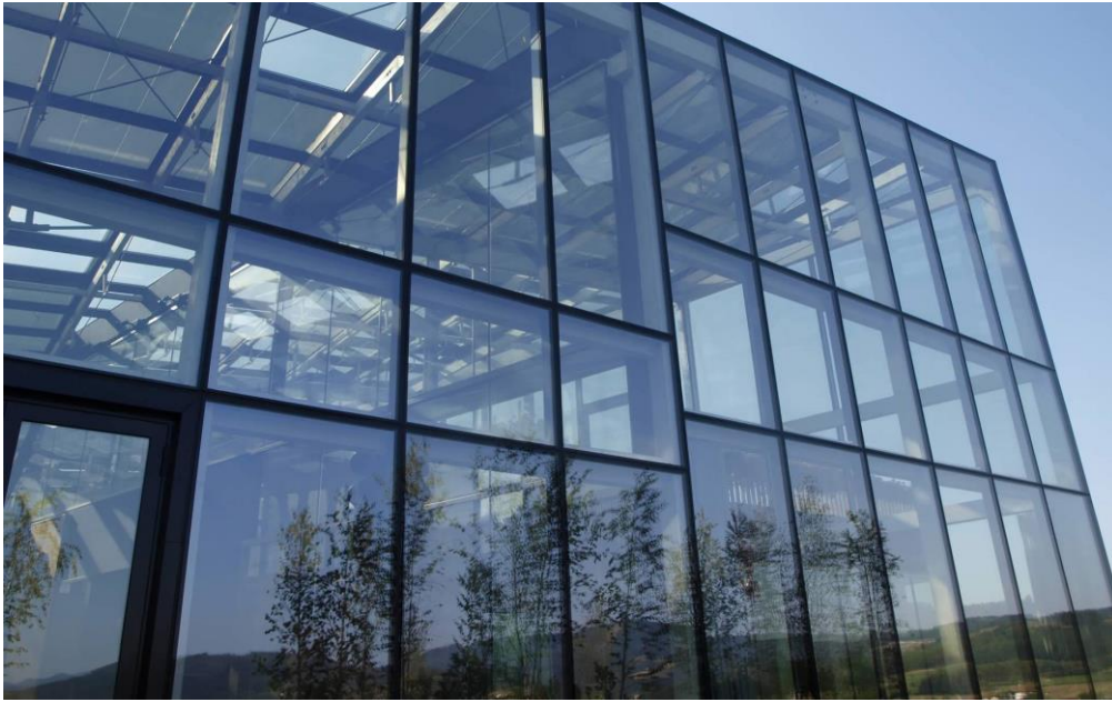
Figura 5-18 Muro Cortina. Fuente: ( https://cosmosglasssolution.com/Blog/beneficios-de-usar-muro-cortina-en-construcciones-actuales/ )
