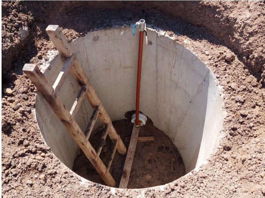
En el otro extremo del caño se debe colocar el elemento que permitirá introducir la presión de agua. Éste consiste en un ramal reducción del diámetro del caño colector al diámetro de 110mm. El ramal se conecta en un extremo al caño colector y en el otro se le coloca una tapa, y en la reducción de 110mm se conecta un caño de altura suficiente como para permitir llenarlo y generar una columna de agua de 2m.
