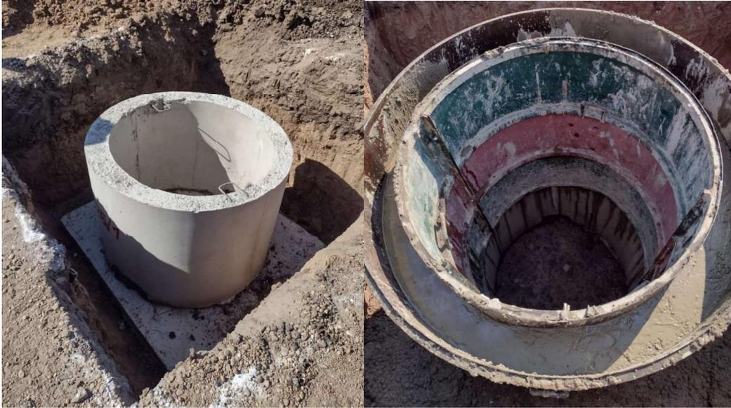
Por último se coloca de forma provisoria la tapa superior para que no exista la posibilidad de que se den accidentes por caída de personas dentro de la boca de registro. Luego se quitará la tapa para realizar los trabajos de empalme de cañerías, prueba hidráulica y ejecución del cojinete. Para finalizar colocando la tapa de fundición.
