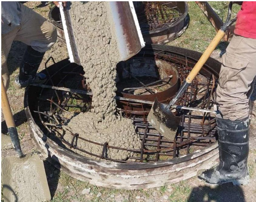
Todos los elementos prefabricados se deben realizar con hormigón tipo H21, y es de vital importancia el vibrado durante la colocación. Ésta acción se realiza mediante vibrador aguja.
