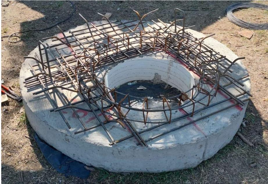
Su ejecución se realiza mediante un encofrado circular de 0,20m de altura con diámetro exterior de 1,60m. A su vez, se coloca un encofrado interior de forma excéntrica para posibilitar el ingreso del personal. Una vez colocada la armadura de resistencia y los ganchos de manipulación, se procede a humedecer el suelo y los encofrados para luego colocar el hormigón como se ilustra en la siguiente fotografía.
