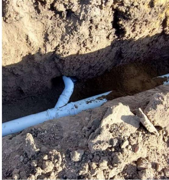
Para evitar que ingrese suelo a la cañería se tapa el extremo hembra de la reducción de 110mm y luego de que se haya tendido el colector en toda la longitud del tramo se procede a realizar la excavación y el tendido de la cañería para todas las conexiones domiciliarias. Al igual que para el caso de las cañerías del colector, a ésta también se la debe apoyar sobre una cama de arena.
