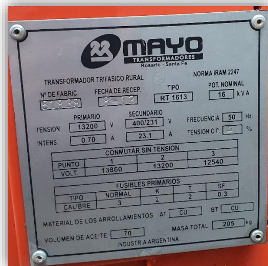
(Transformador Trifásico 13,2/0.4-0,231 Kv – 16 kVA)
