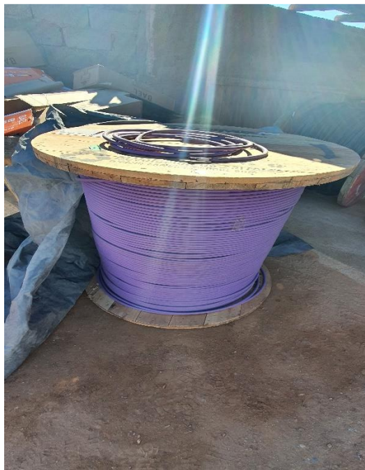
(Bobina de conductor Sinténax de 4mm 2 utilizado vía subterránea)
