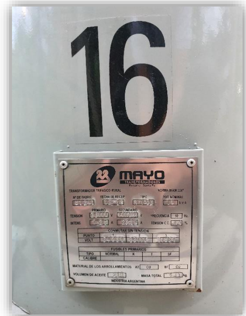
(Transformador Trifásico 13,2/0.4-0,231 Kv – 16 kVA con su respectiva placa de datos técnicos)
