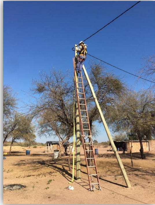
(Instalación de una de las luminarias proyectadas)
