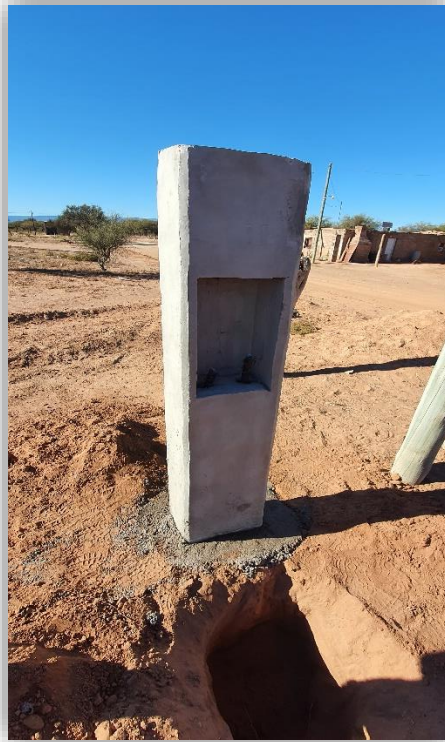
(Pilar de hormigón para la instalación de uno de los tableros)
