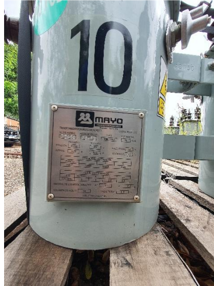
(Transformador Monofásico 13,2/0,4 kV – 10 kVA)
