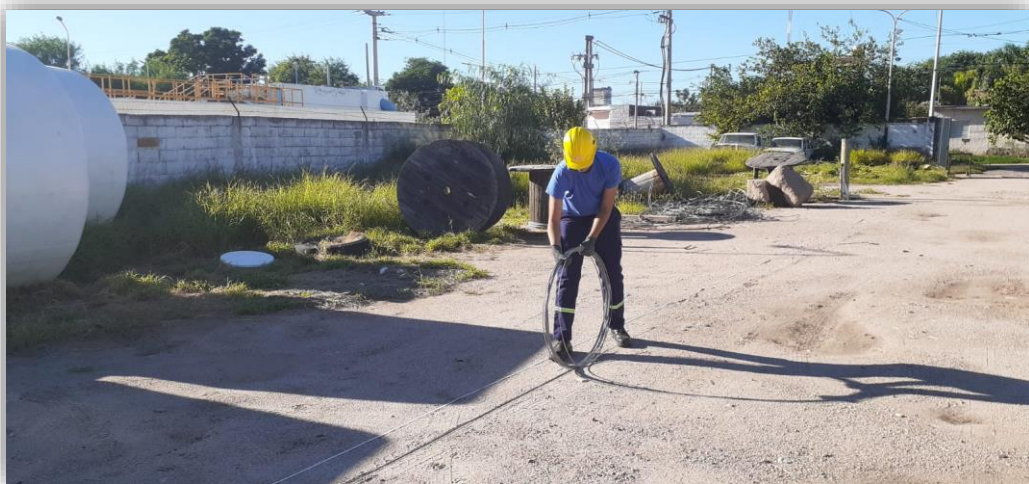
(Enrollamiento de cable de Acero Galvanizado MN100 para su entrega a la empresa contratista)
