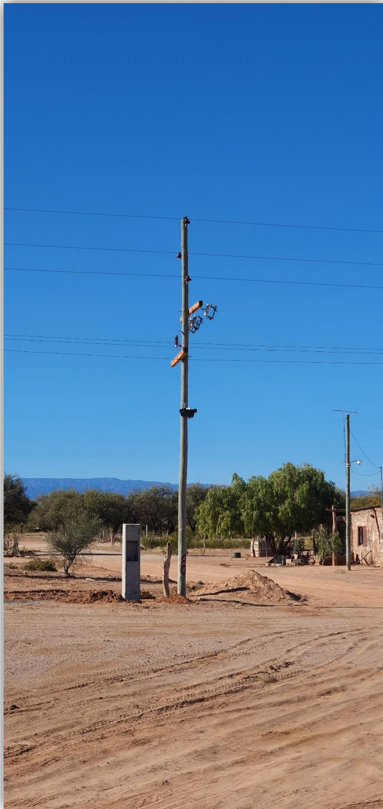
(Mismo apoyo de alineación LMT con pilar de hormigón, pero con vista ampliada)
