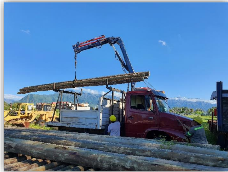
(Carga de postes de 7,5m)
