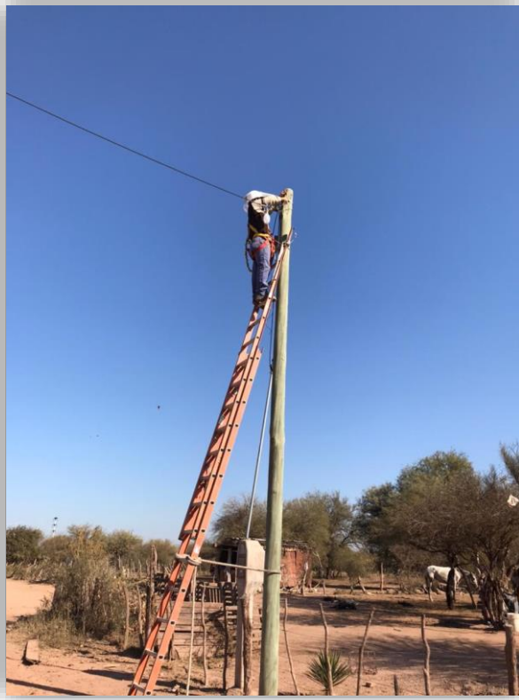
(Recambio de luminaria defectuosa con faltante de artefacto antivandálico y tulipa)
