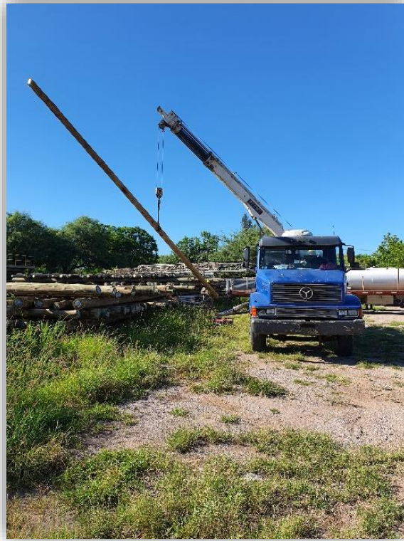
(Carga de postes de 11m)
