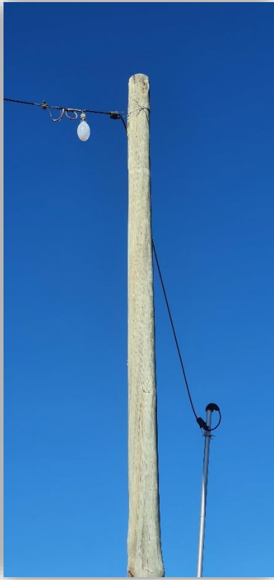
(Recambio de luminaria defectuosa con faltante de artefacto antivandálico y tulipa)
