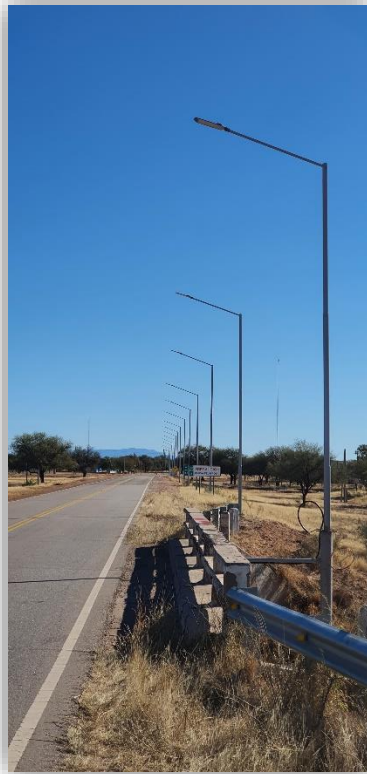
(Distribución de las columnas metálicas con luminarias ya instaladas a lo largo de la RPN°28)
