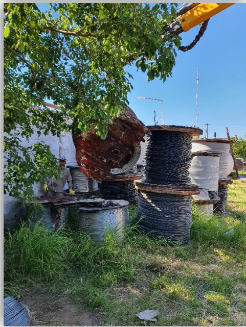
(Carga de bobina con conductor de aluminio desnudo de 25mm 2 a la empresa contratista)
