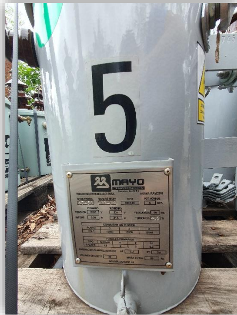
(Transformador Monofásico 13,2/0,4 kV – 5 kVA)
