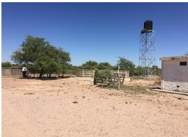
Figura 3: Tanques australianos y tanque elevado en la localidad de Entre Ríos
