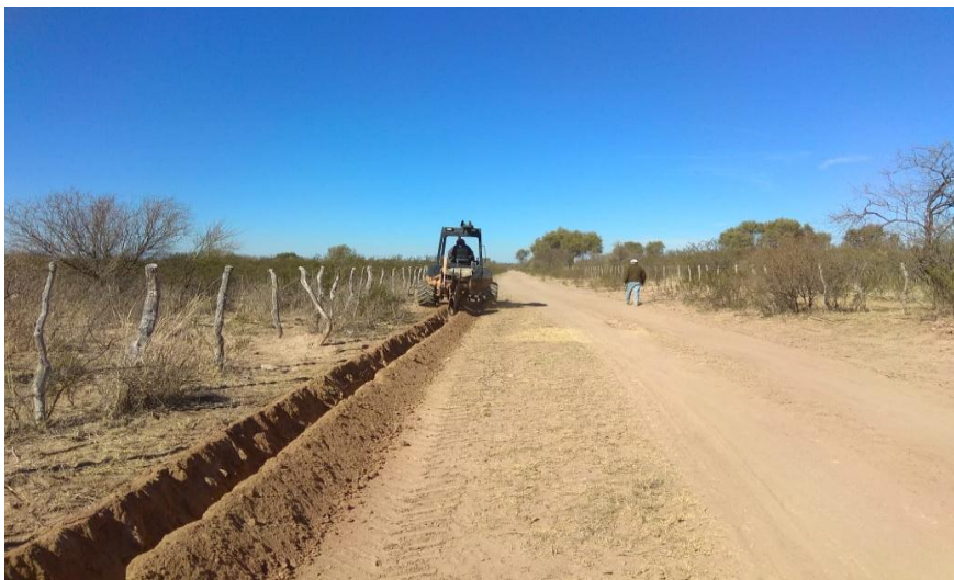
Figura 7: Excavación para la ampliación.
