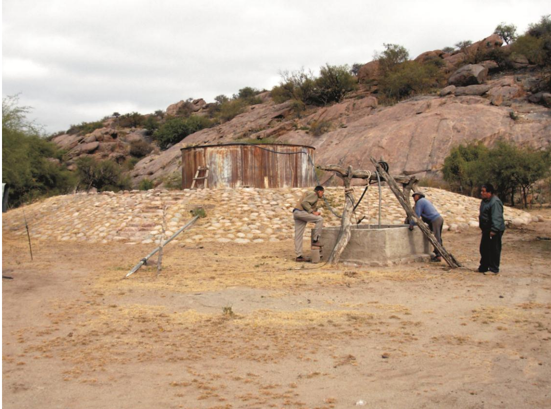
Foto 5- Pozo cavado en la localidad de El Abra
