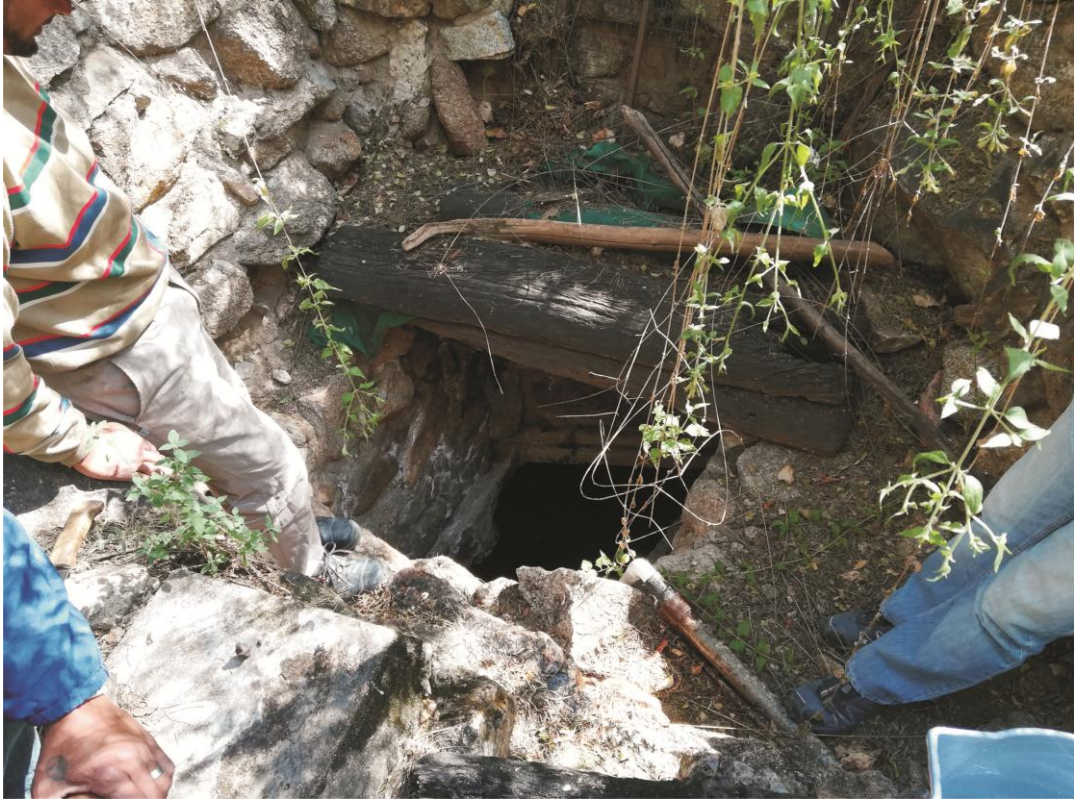
Foto 3- Captación de vertiente en Punta del Negro
