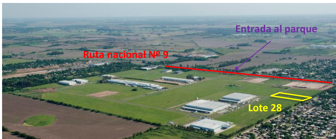
Figura 12-1. Ubicación del terreno en el parque industrial Campana. Fuente: Elaboración propia.
